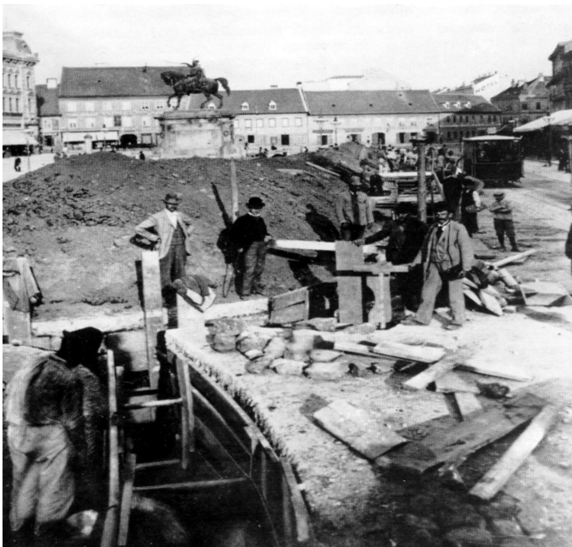
Slika 1. Gradnja kanala na Jelačićevom trgu 1898.godine [2]
