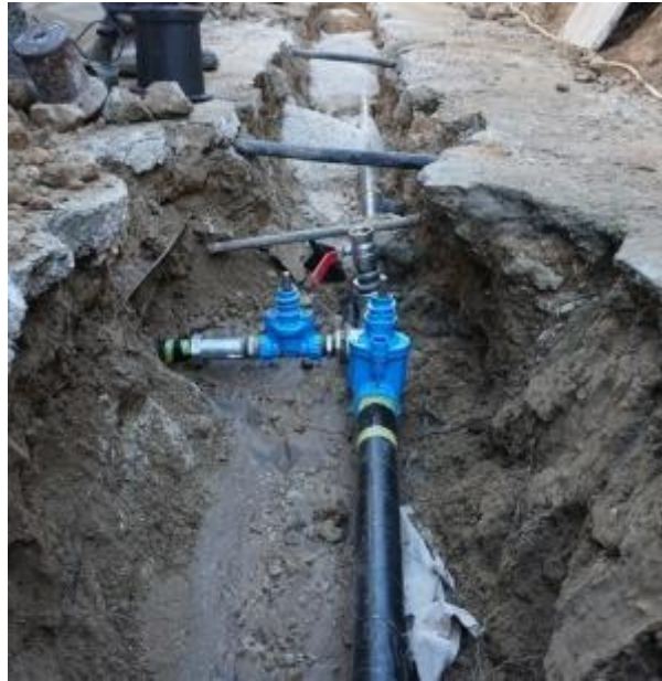
Slika 20. Cjevovod za dopremanje vode[19]
