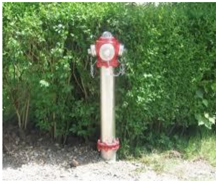
Slika 14. Nadzemni hidrant [17]
