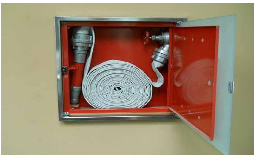
Slika 13. Izvedba zidnih hidranata i ormarića[16]
