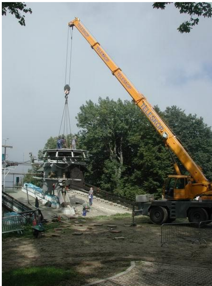
Slika 49. Montaža pogonskog okretnog kotača [7]
