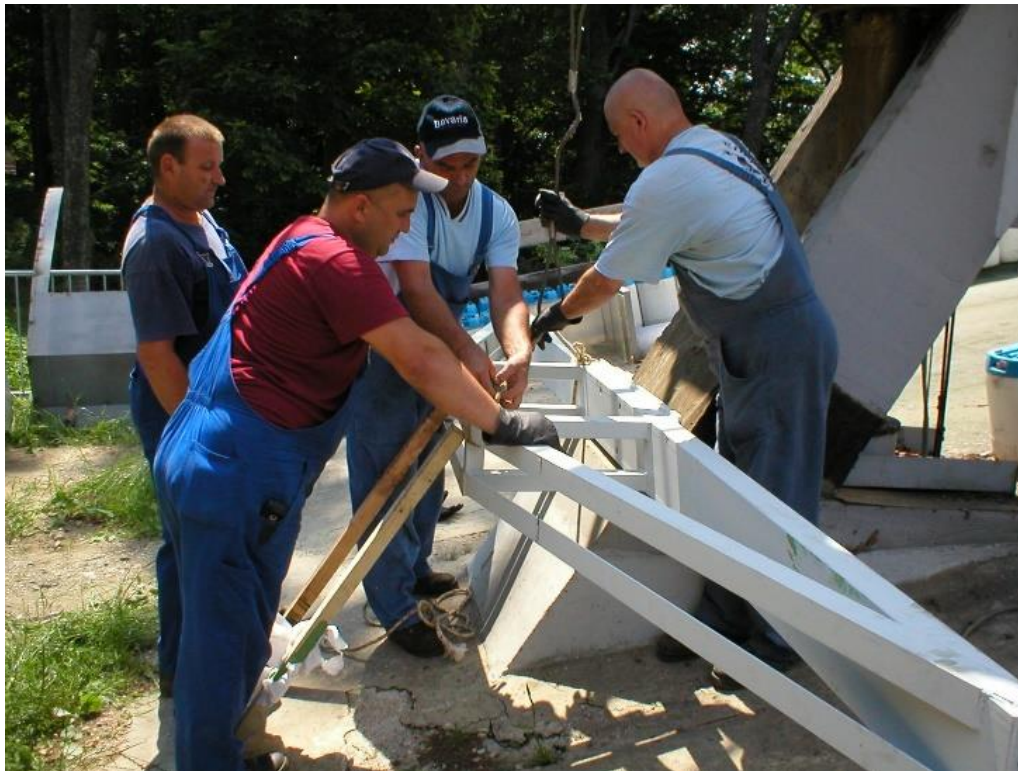
Slika 26. Montaža naprave za preuzimanje nosivog užeta s pogonskog kotača [7]
