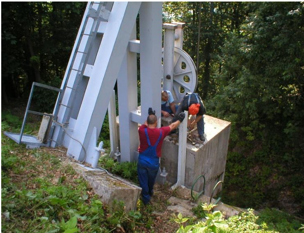
Slika 25. Montaža naprave za podizanje protuutega (2) [7]
