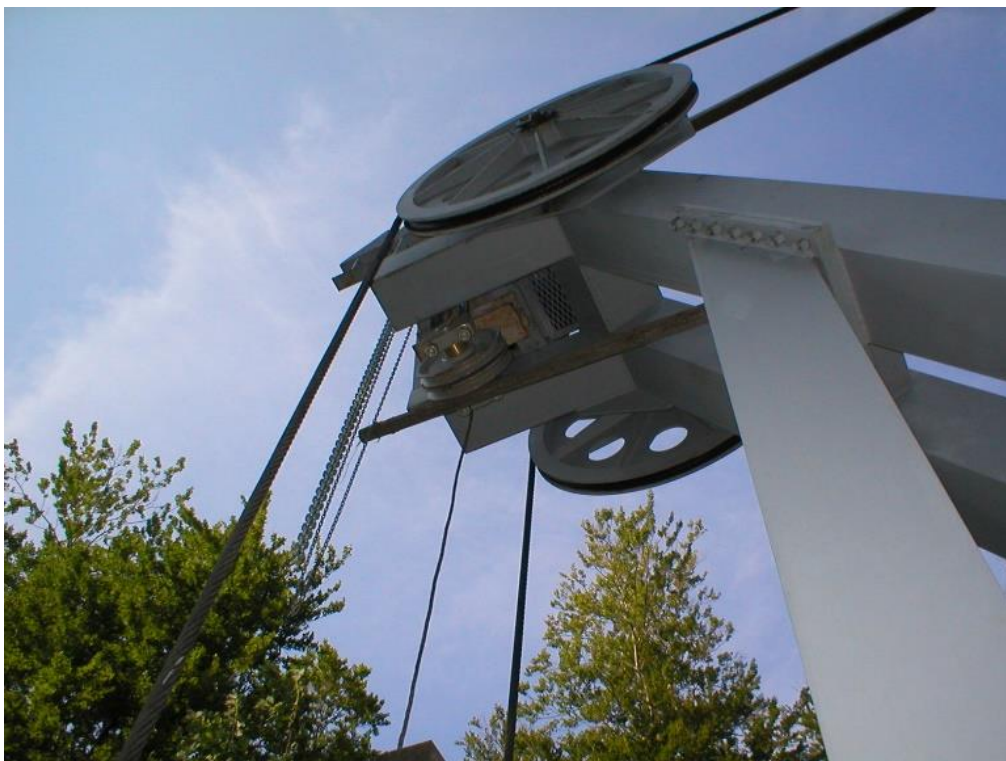
Slika 24. Montaža naprave za podizanje protuutega (1) [7]
