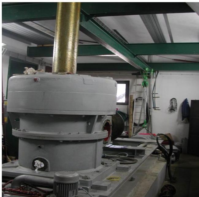
Slika 35. Montirani voziček na stropne traverze [7]
