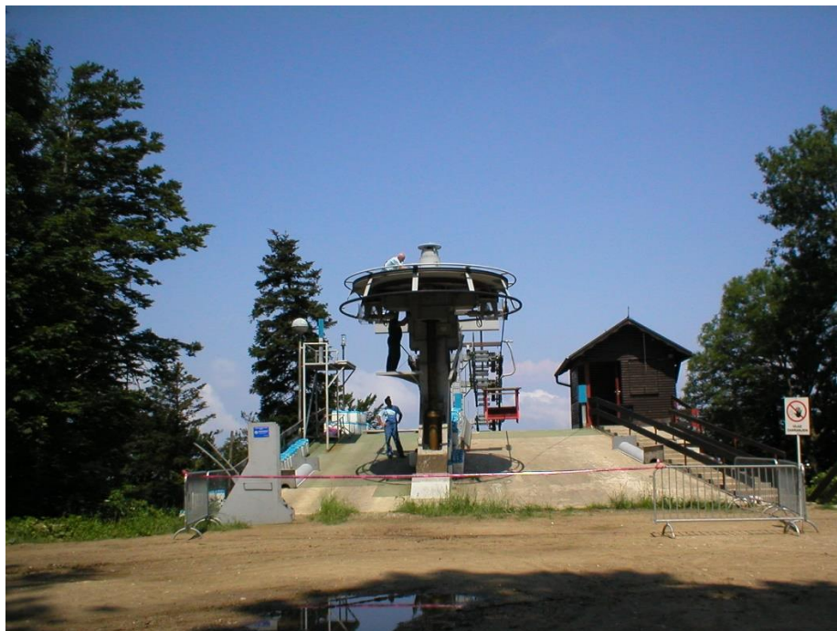
Slika 31. Uklonjena oplata dvodijelnog vratila [7]
