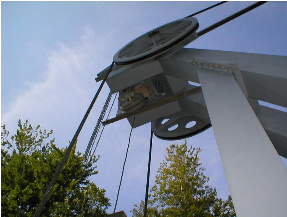
Slika 24. Montaža naprave za podizanje protuutega (1) [7]
