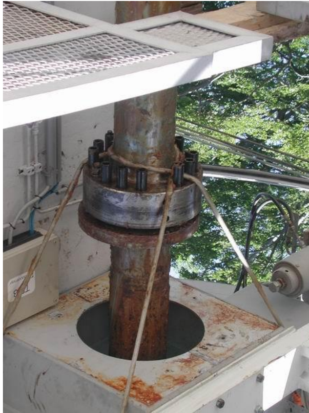
Slika 40. Demontaža spojnih vijaka [7]
