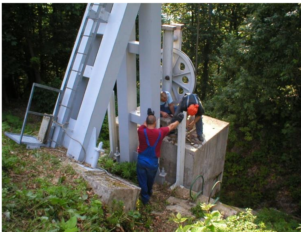
Slika 25. Montaža naprave za podizanje protuutega (2) [7]
