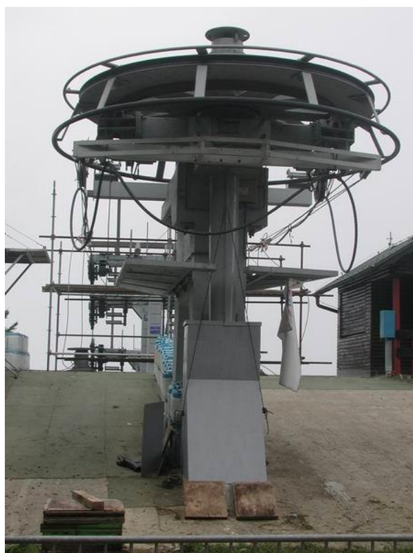
Slika 51. Montiran pogonski okretni kotač [7]
