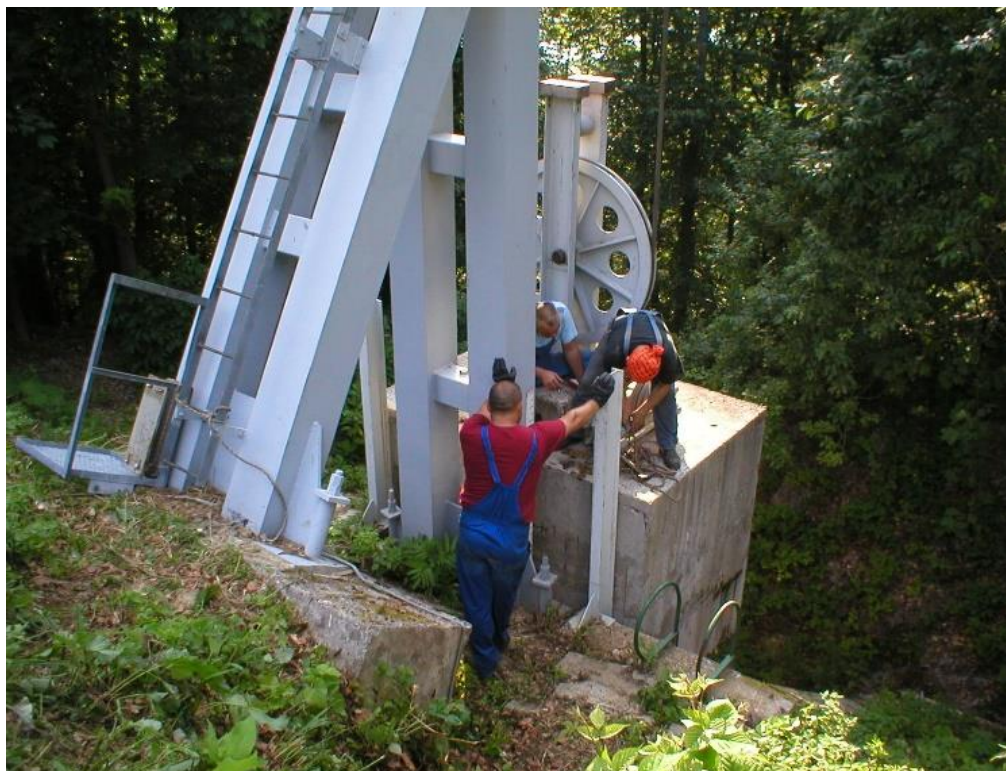
Slika 25. Montaža naprave za podizanje protuutega (2) [7]
