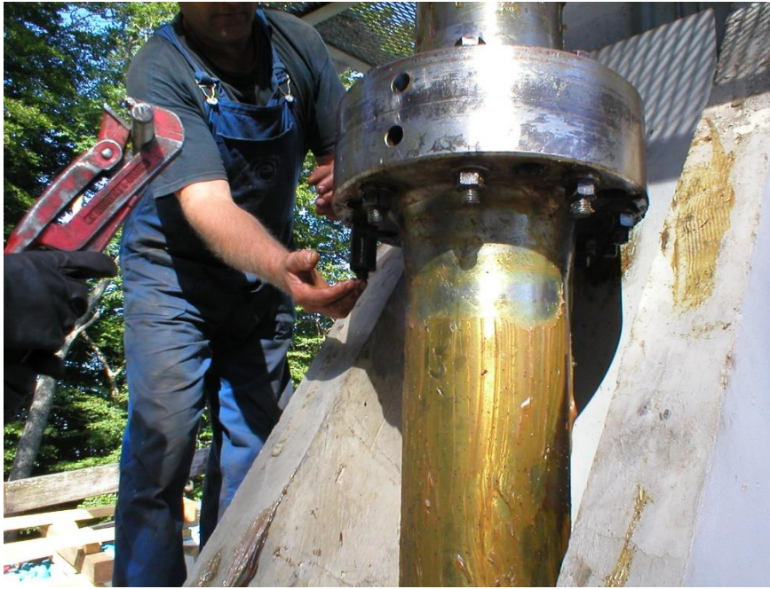
Slika 39. Demontaža prirubničkog spoja [7]
