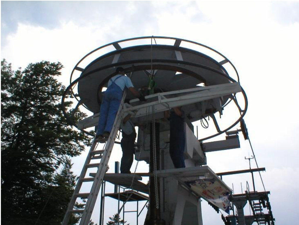
Slika 27. Montaža naprave za preuzimanje nosivog užeta s pogonskog kotača (1) [7]
