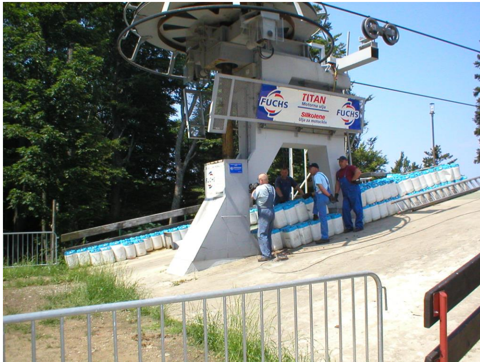
Slika 29. Oplata dvodijelnog vratila prije demontaže [7]
