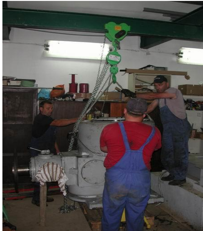
Slika 37. Demontaža reduktora [7]
