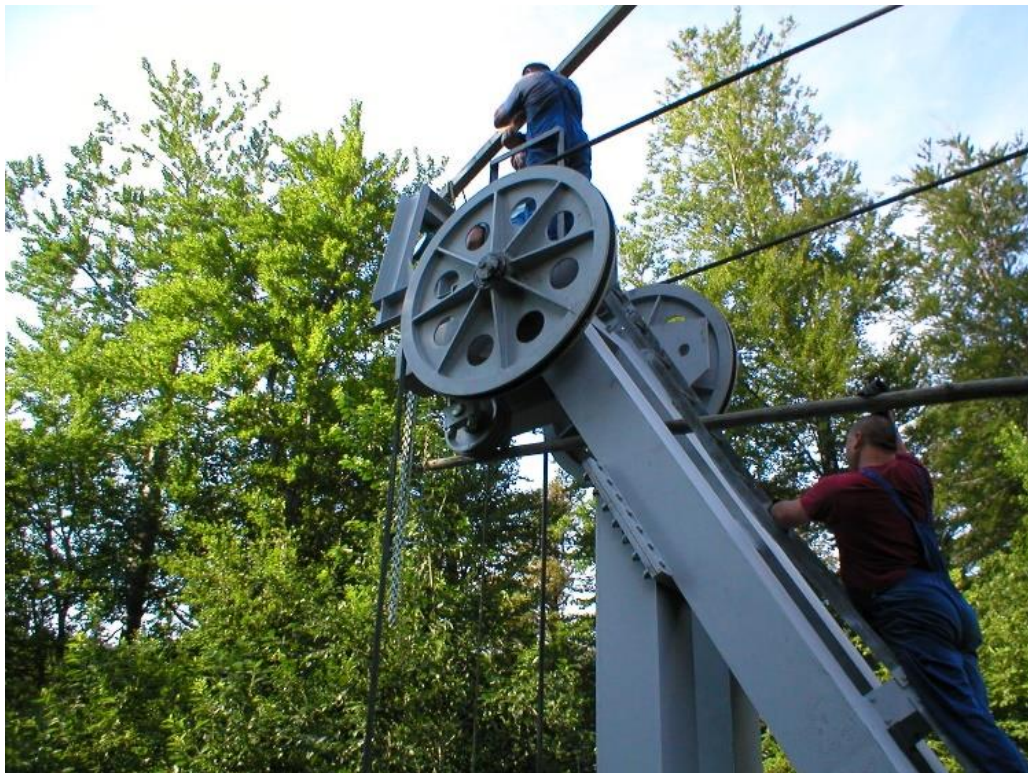
Slika 23. Montaža naprave za podizanje protuutega [7]
