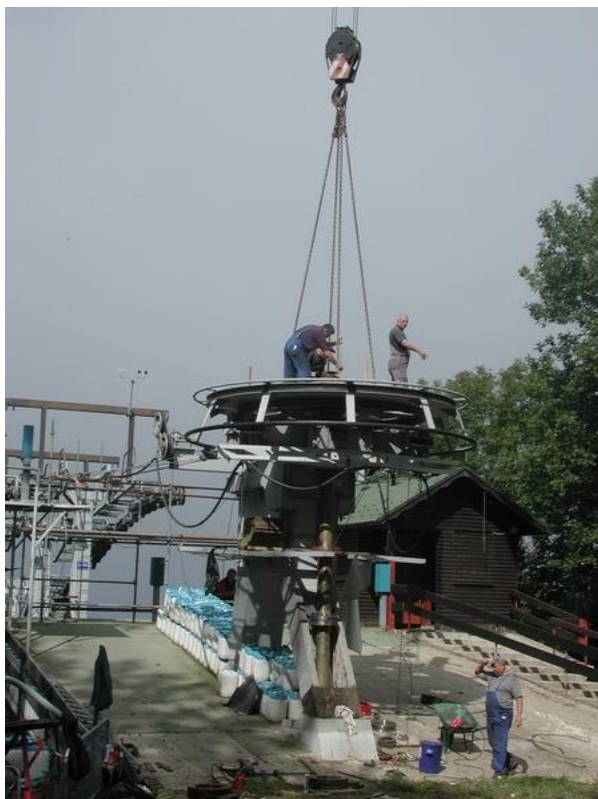
Slika 50. Montaža pogonskog okretnog kotača (1) [7]
