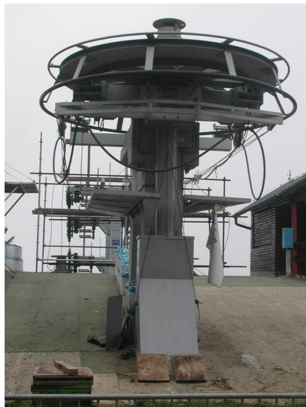
Slika 51. Montiran pogonski okretni kotač [7]
