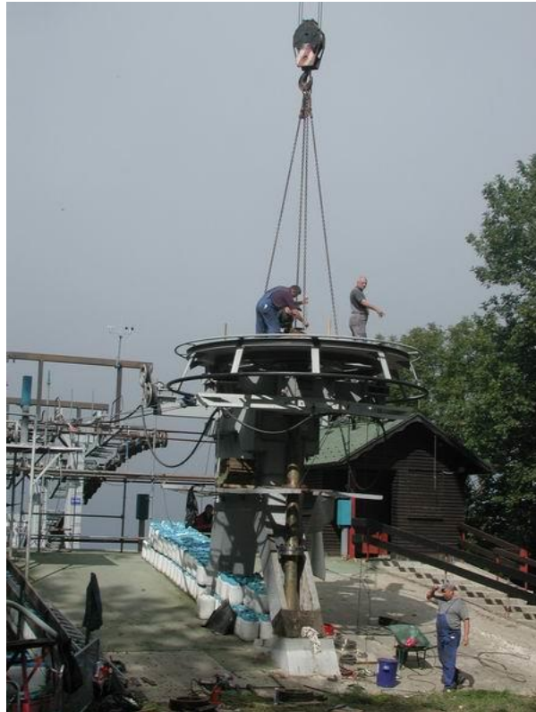
Slika 50. Montaža pogonskog okretnog kotača (1) [7]
