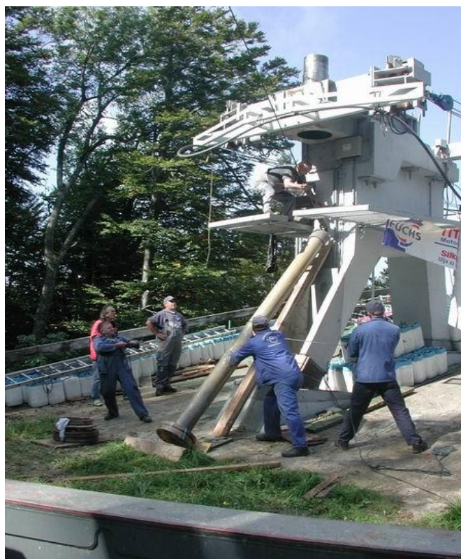
Slika 46. Montaža dvodijelnog vratila [7]
