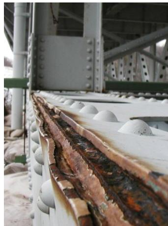
**Slika 17.** Korozija u procijepu između dva jednaka metala na konstrukciji mosta
