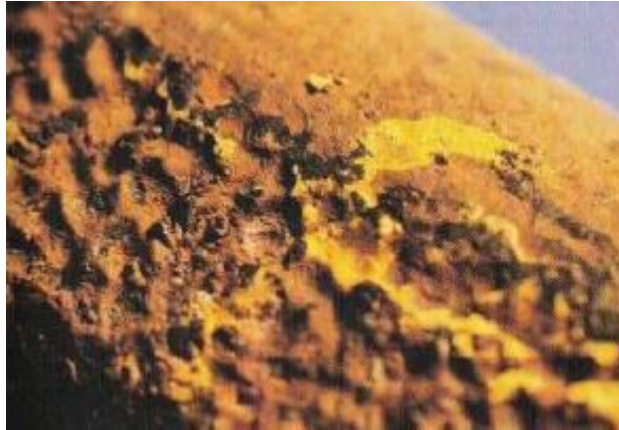
Slika 7. Plinska korozija ( http://bs.scribd.com/doc/219168839/Kotlovski-Materijali-i-Opterecenja , Pristupljeno 20.12.2022.)
