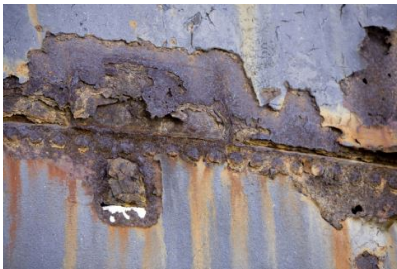
Slika 15. Potpovršinska korozija
