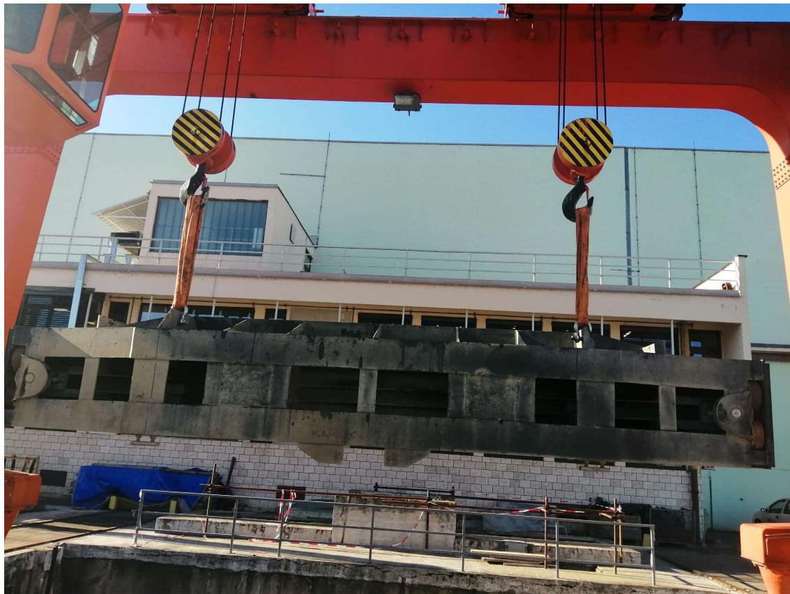
Slika 4.17 Izvlačenje segmenata zatvarača portalnom dizalicom
