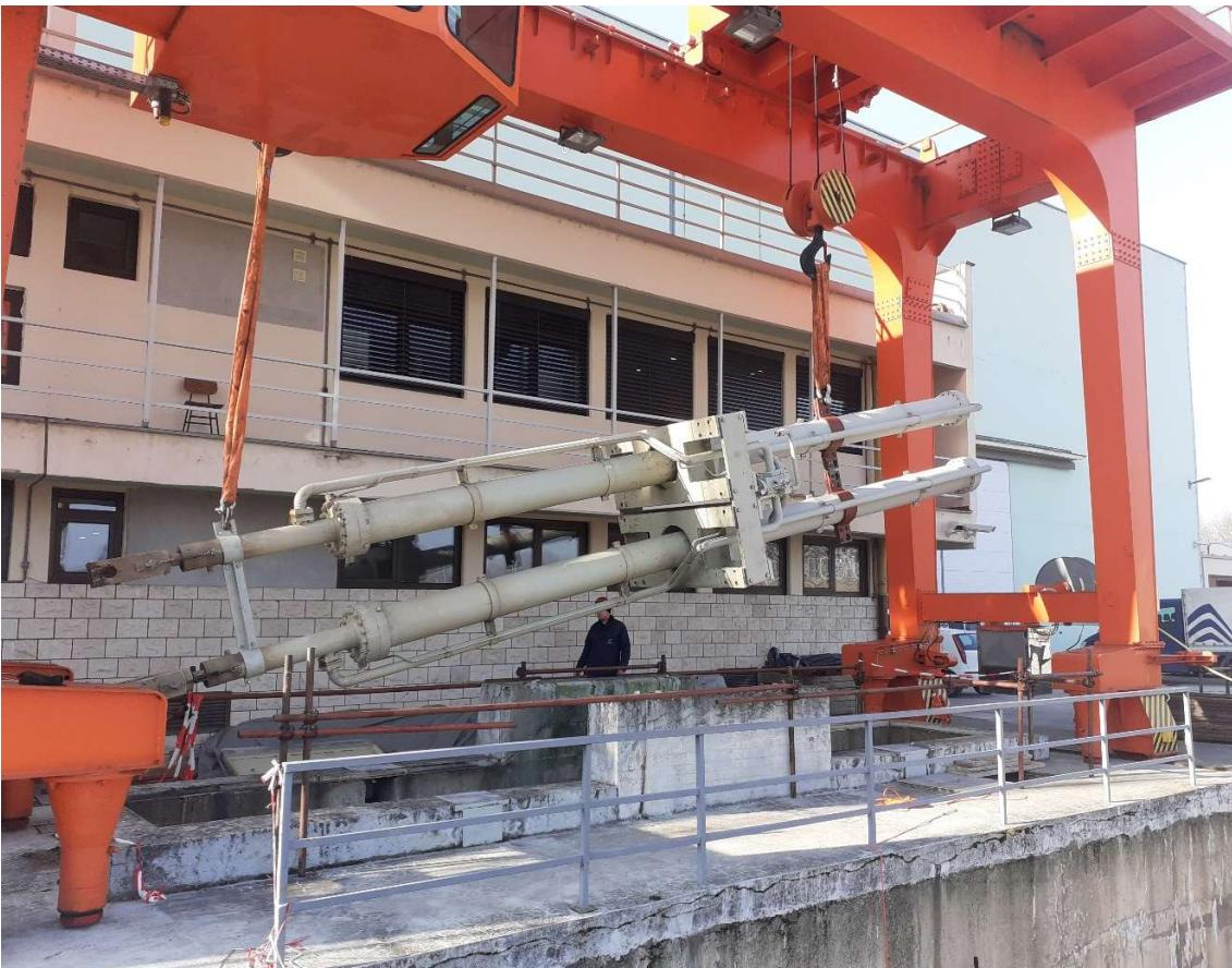
**Slika 4.16 Izvlačenje servomotora portalnom dizalicom**
