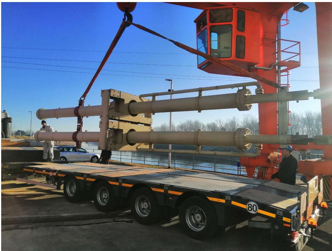
**Slika 4.18** Utovar servomotora na labudicu za transport
