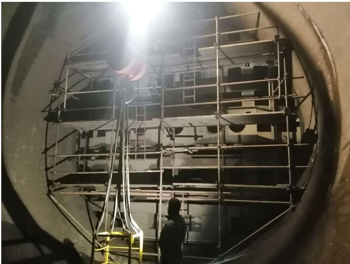
**Slika 4.13** Skela u usisnoj cijevi agregata A
