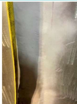
Slika 2. PT zavara između ploča brtvene stijene
