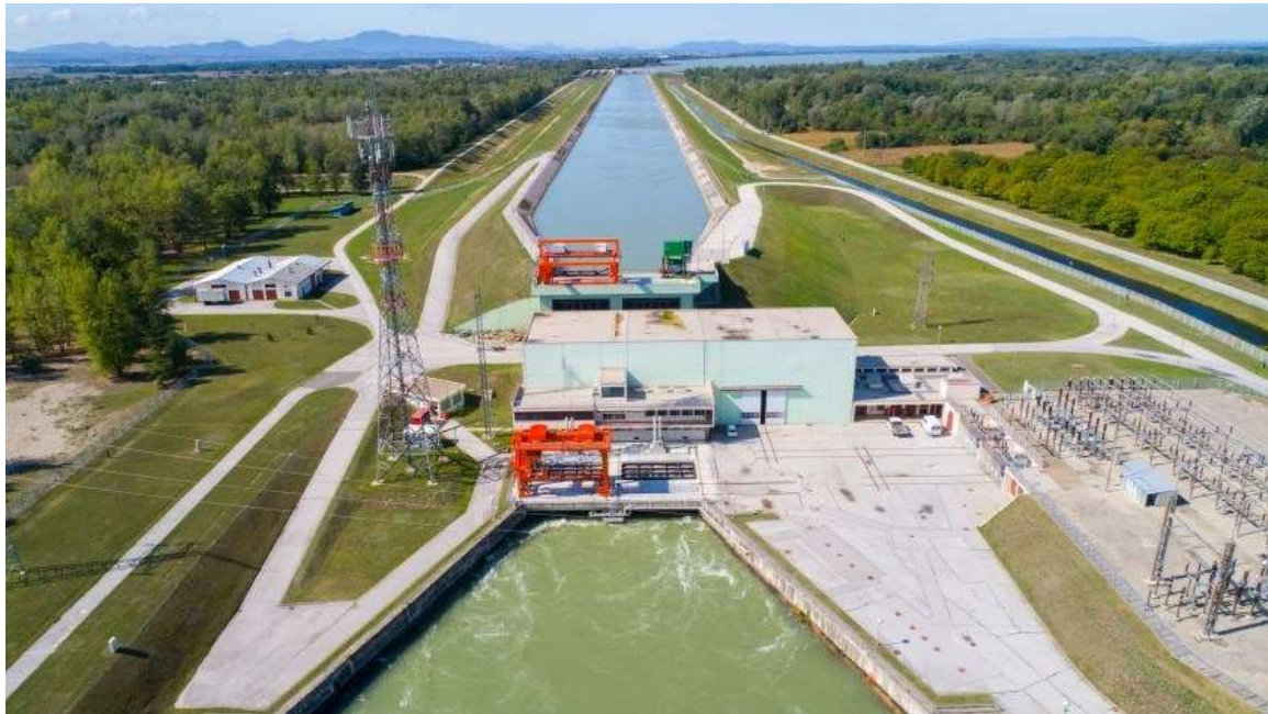
Slika 1.2 Hidroelektrana Čakovec snage 77,44 MW [2]
