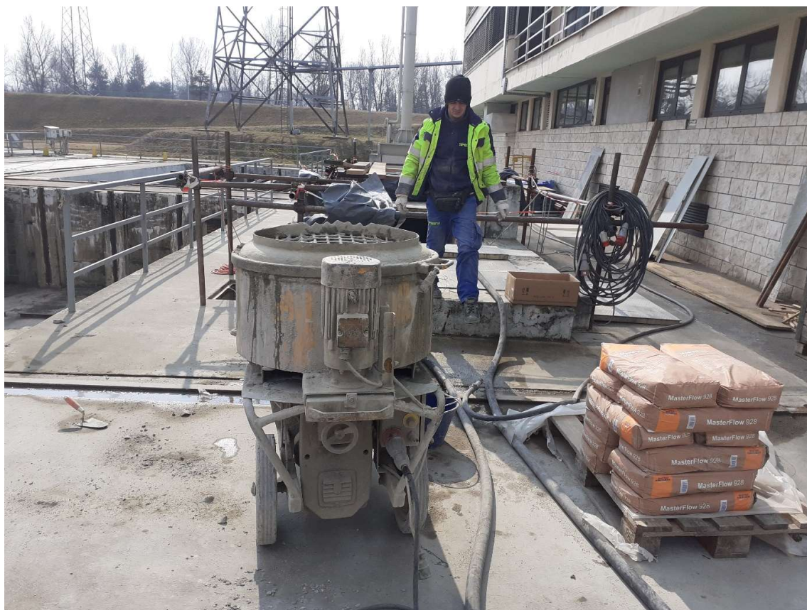
Slika 4.28 Injektiranje podložnog betona visokotlačnom pumpom
