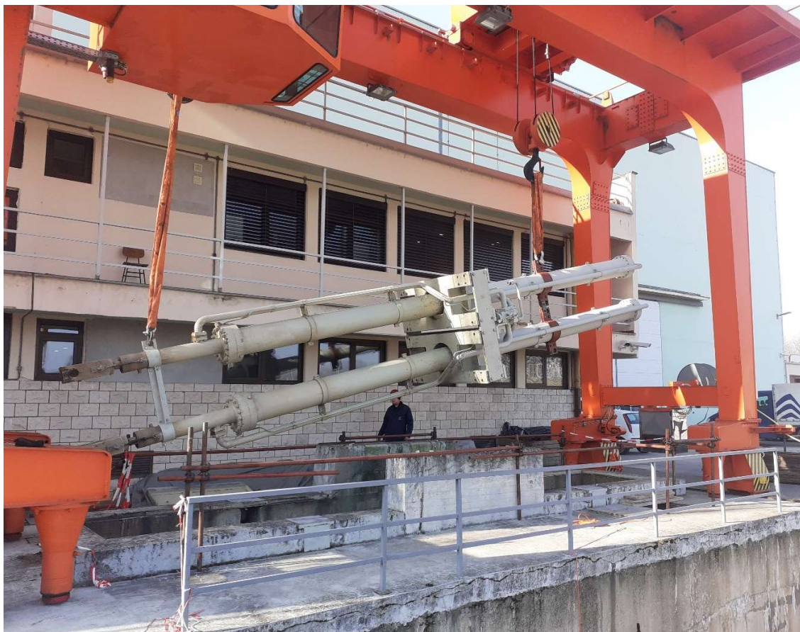
Slika 4.16 Izvlačenje servomotora portalnom dizalicom
