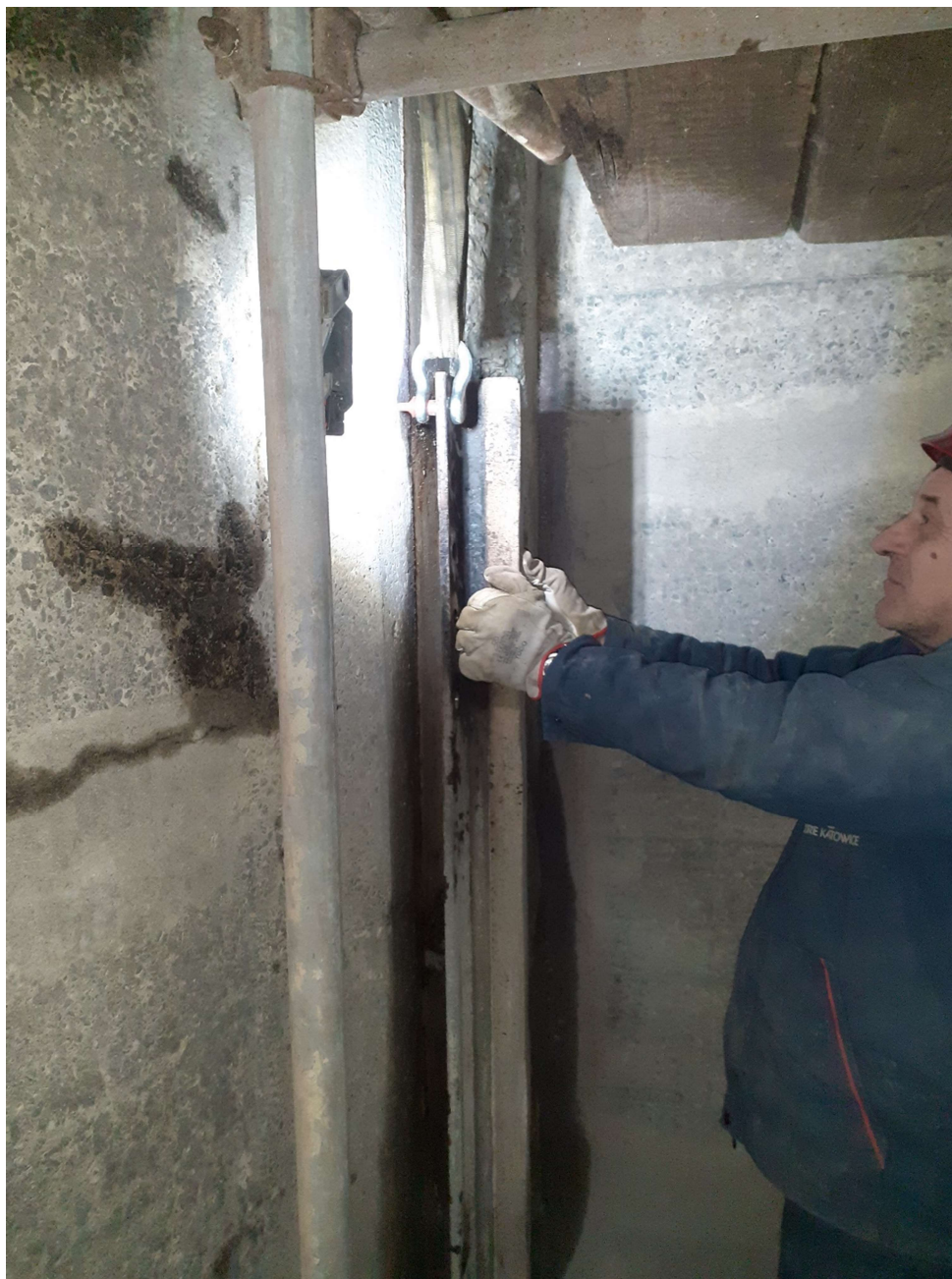
Slika 4.25 Demontaža starih tračnica
