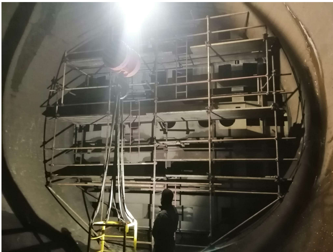
Slika 4.13 Skela u usisnoj cijevi agregata A
