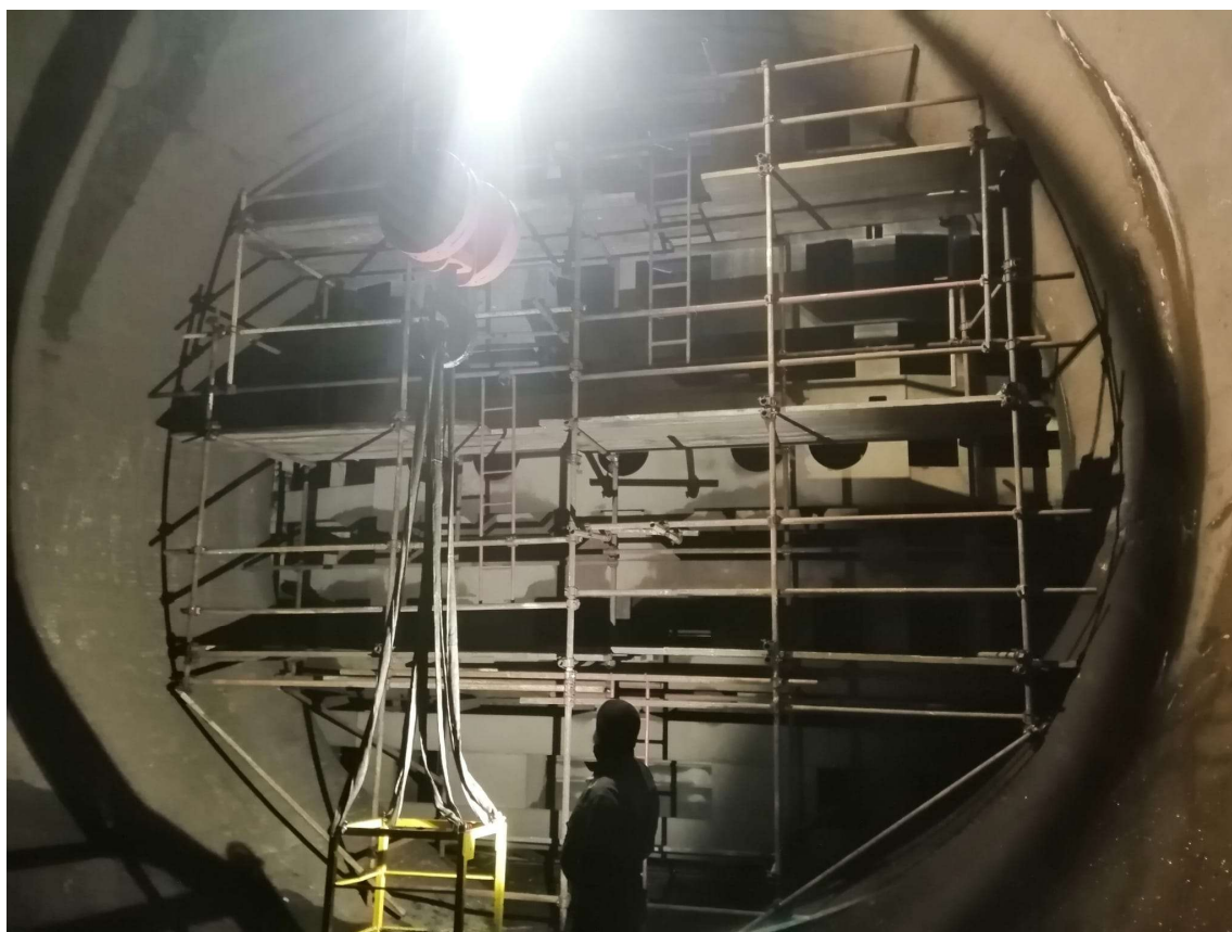
Slika 4.13 Skela u usisnoj cijevi agregata A
