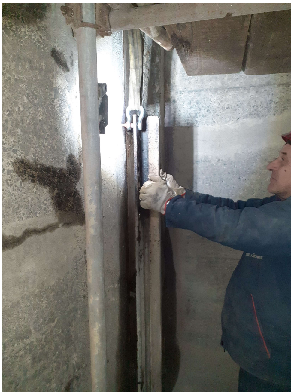
Slika 4.25 Demontaža starih tračnica
