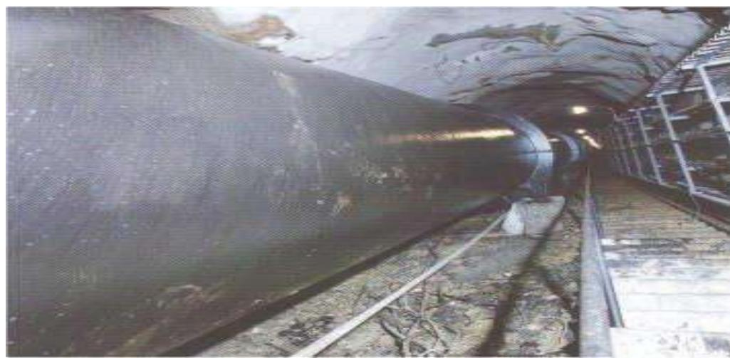
Slika 3. Tlačni cjevovod na Hidroelektrani Rijeka [2]
