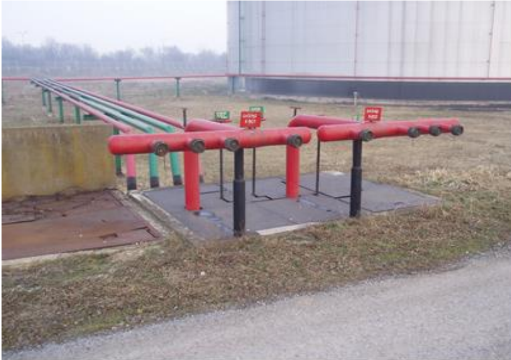
Slika 10: Priklučci polustabilnog sustava za gašenje požara zračnom pjenom [10] 13
