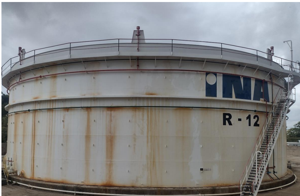
Sl. 4. Spremnik s plivajućim krovom [Vlastita fotografija]
