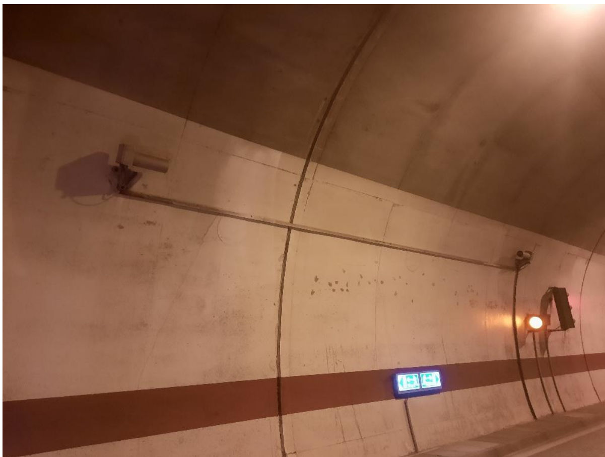
Slika 14. Senzori vidljivosti i CO (vlastiti izvor)
