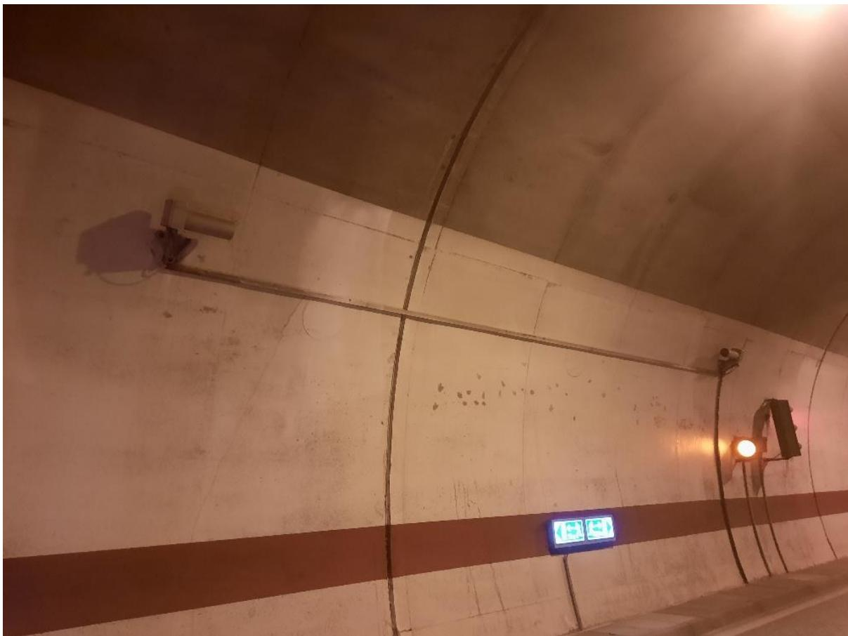
Slika 14. Senzori vidljivosti i CO (vlastiti izvor)
