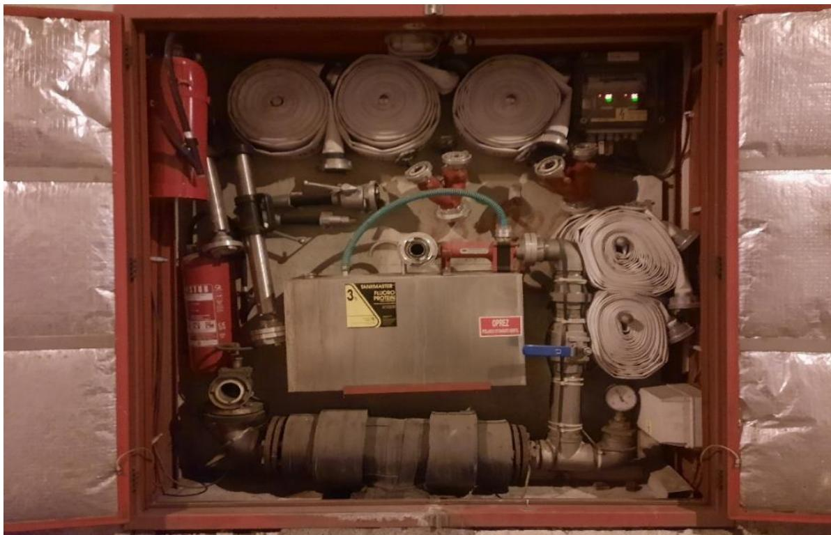
Slika 7. Hidrantski ormar u lijevoj cijevi tunela Mala Kapela (vlastiti izvor)
