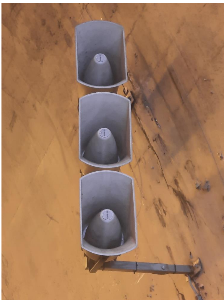
Slika 12. Sustav ozvučenja u tunelu Mala Kapela (vlastiti izvor)
