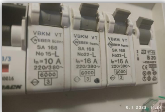
Slika 10. Automatski osigurači u GRO-u
