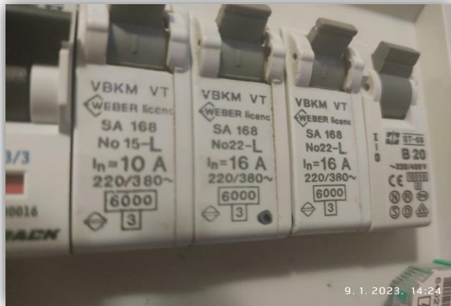
Slika 10. Automatski osigurači u GRO-u
