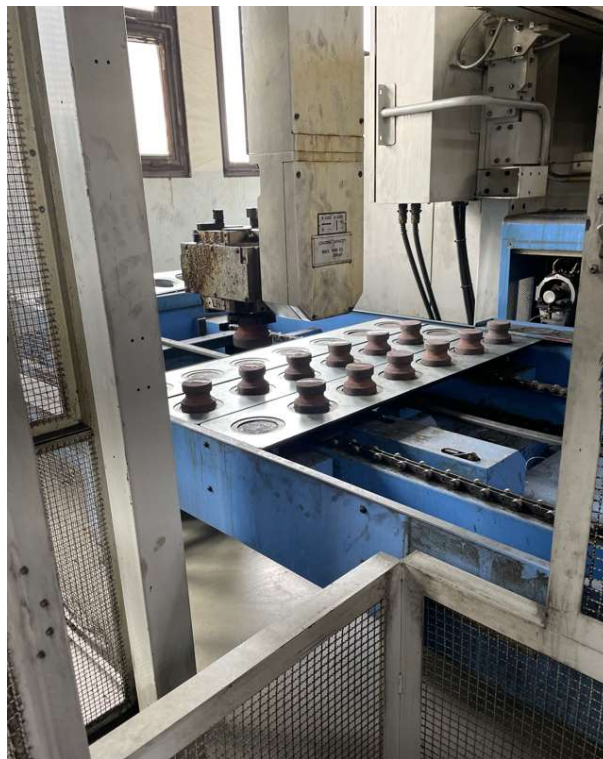
Slika 23. Sustav za automatiziranu izmjenu obradaka u tvrtki OMCO Croatia
