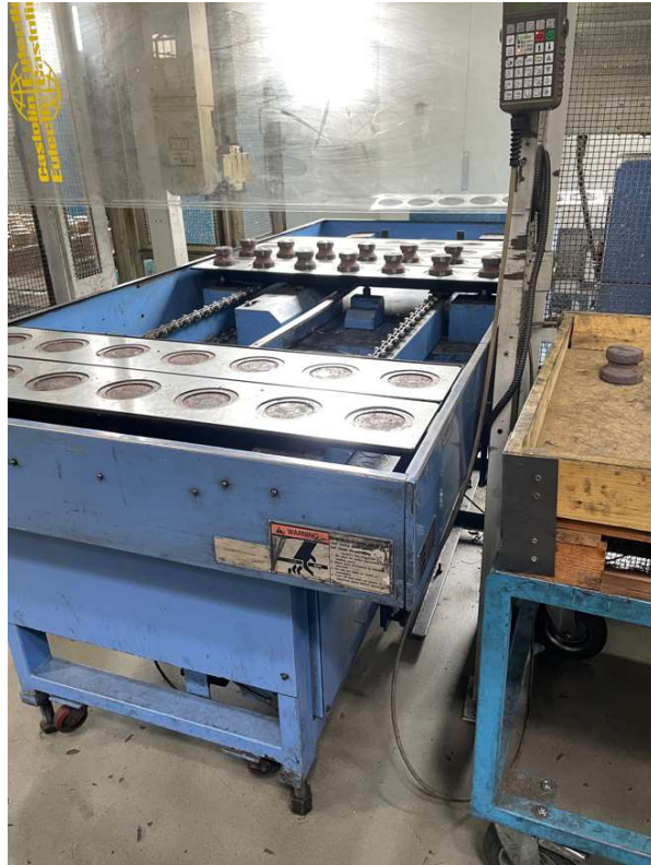
Slika 22. Sustav za automatiziranu izmjenu obradaka u tvrtki OMCO Croatia
