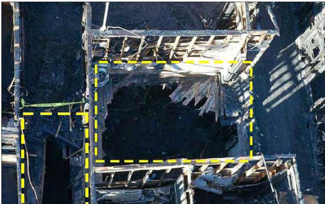
Slika 12. Urušeni dijelovi krova na trećem katu sjevernog krila [6]
