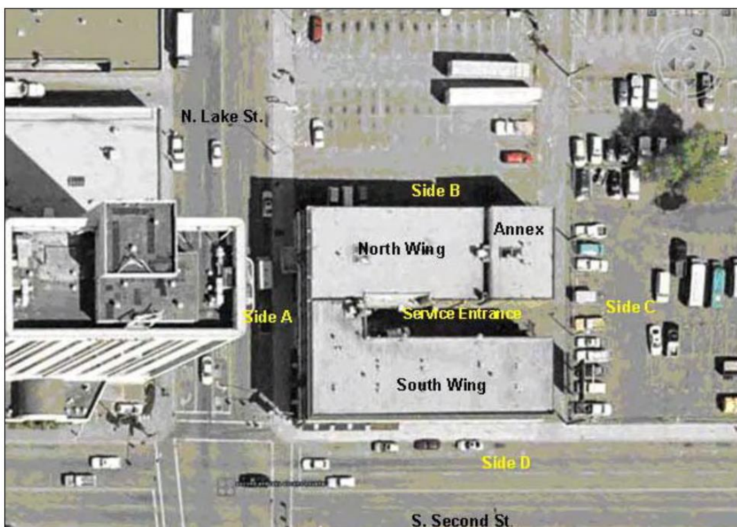
Slika 4. Pogled iz zraka na hotel prije požara [7]
