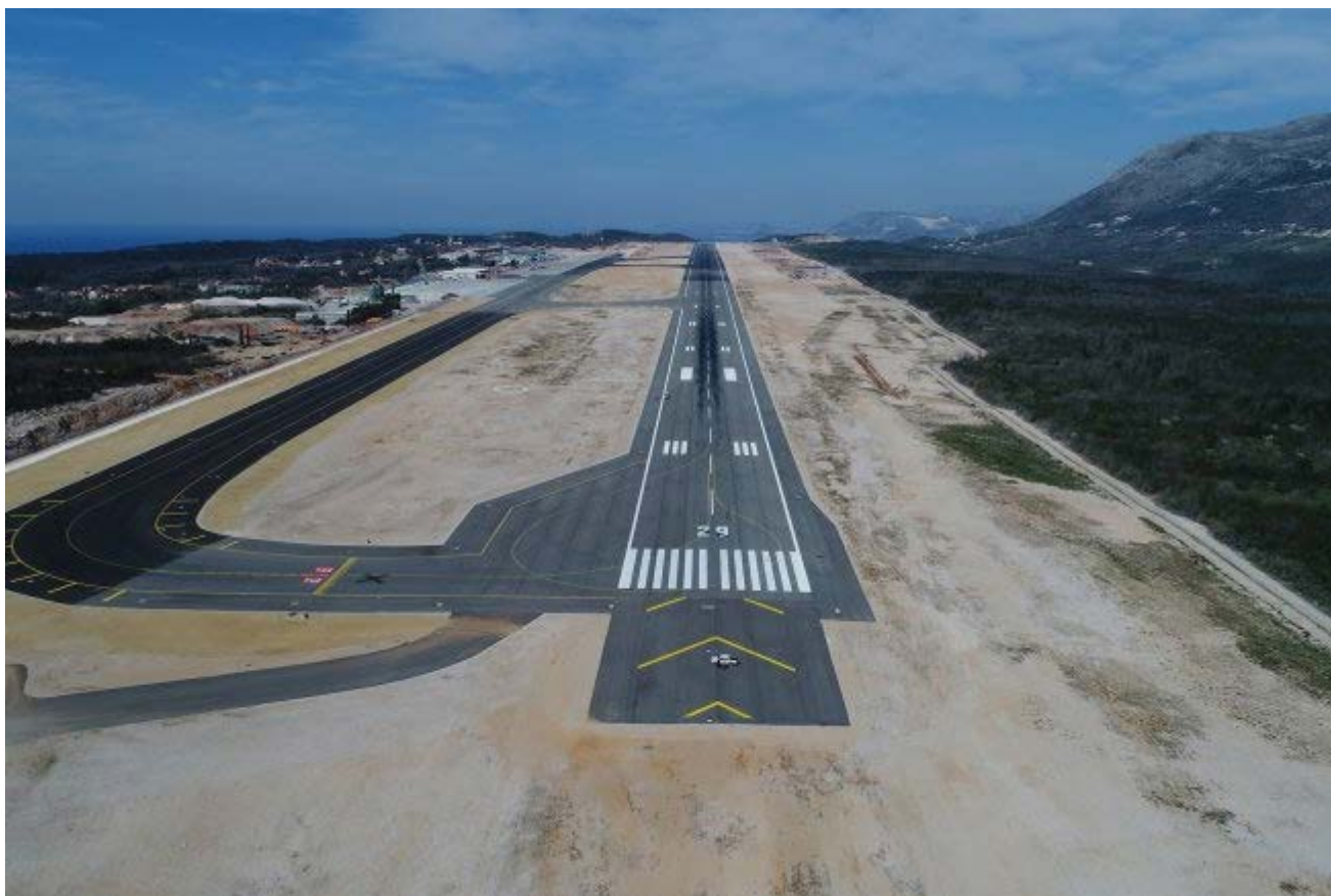
Slika 2. Infrastruktura građenja Zračne luke Dubrovnik [2]
