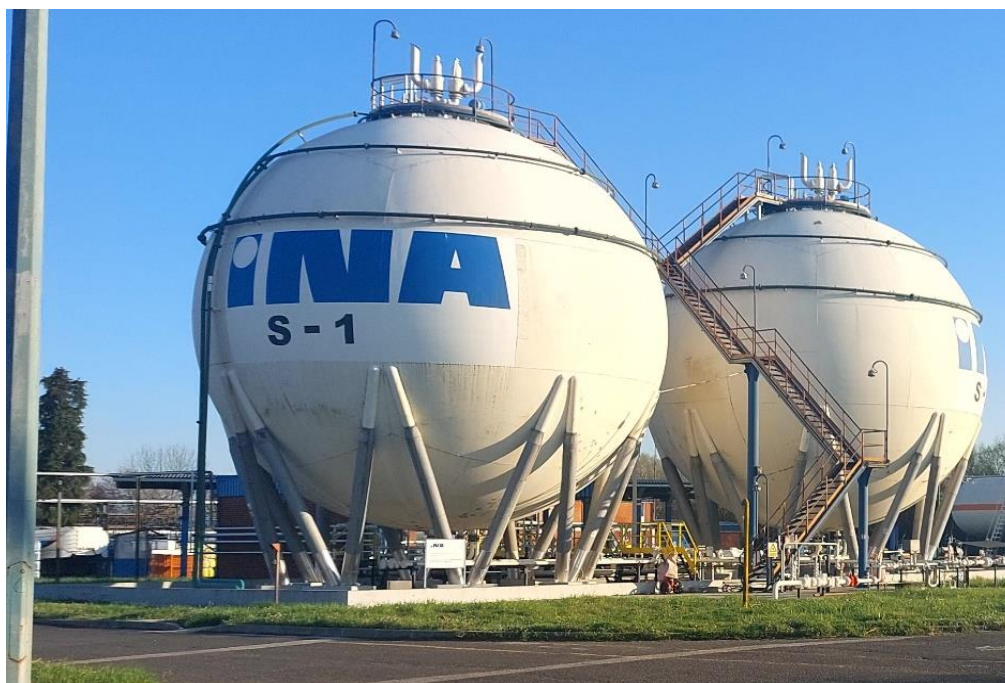
Slika 12. Kuglasti spremnik [8]
