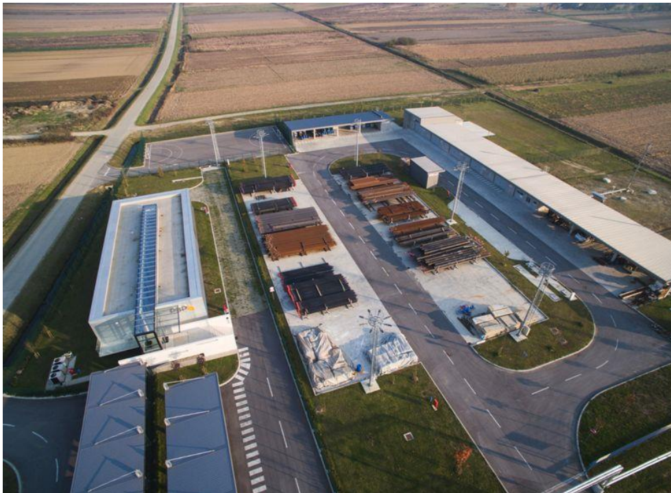
Slika 14. Podzemno skladište plina Okoli [18]
