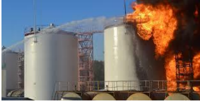
Slika 19. Požar spremnika goriva u Kijevu
