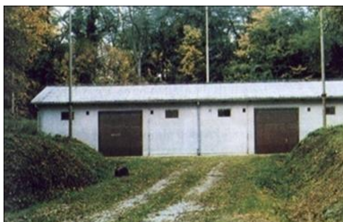
Slika 10. Skladišni objekt vrste S
