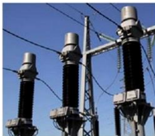
Slika 7. Kombinirani transformator, tip Končar VAU [4]
