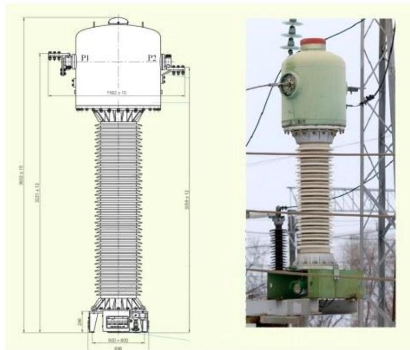
Slika 6. SF6 plinom izolirani ST, tip TGF-110 [4]
