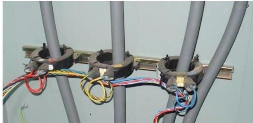
Slika 1. Primjer jednostavne izvedbe NN provlačnog SMT-a [4]
