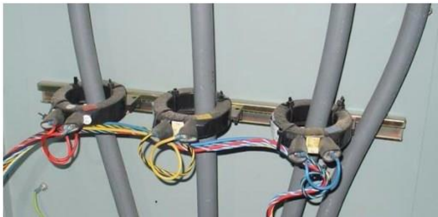
Slika 1. Primjer jednostavne izvedbe NN provlačnog SMT-a [4]
