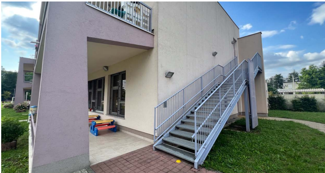
Slika 12. Vanjsko stubište u dječjem vrtiću Rakovac, vlastiti izvor autora
