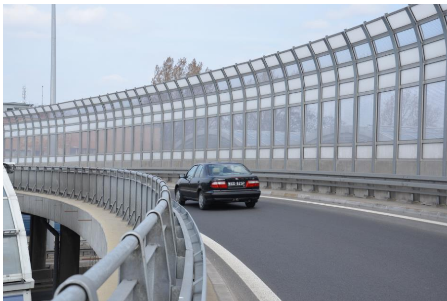
Slika 6.2. Aluminijски paneli
