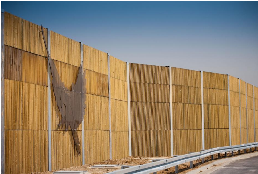
Slika 6.4. Drveni paneli
