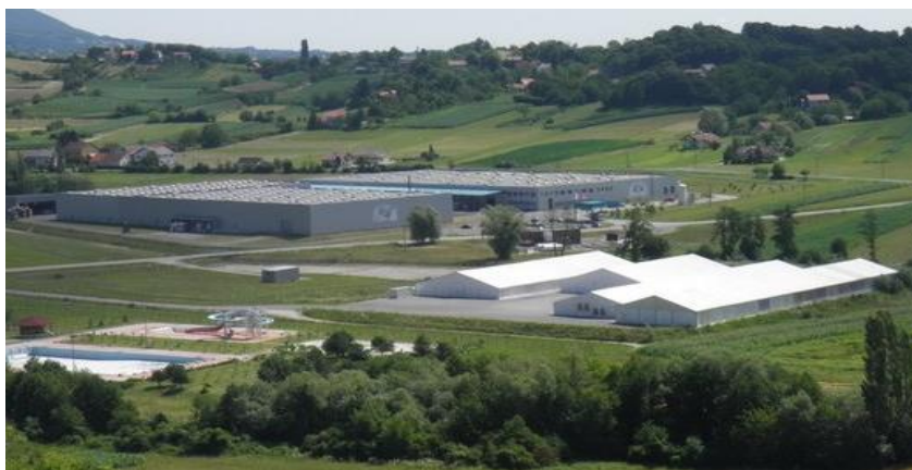
Slika 2.: Proizvodni pogon i skladište punionice vode Jana
