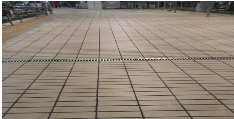
Slika 14.: Protu klizni podovi i odvodni kanali
