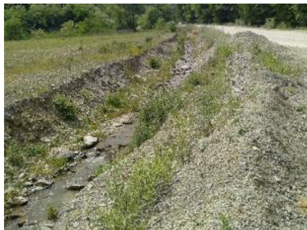
Slika 56. Kanalizirani dio vodotoka
