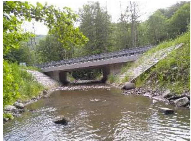
Slika 10. Ispred mosta na koti 321 m nv
