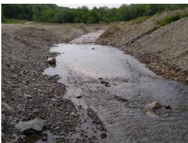
Slika 57. Kanalizirani dio toka s branom za taloženje pijeska
