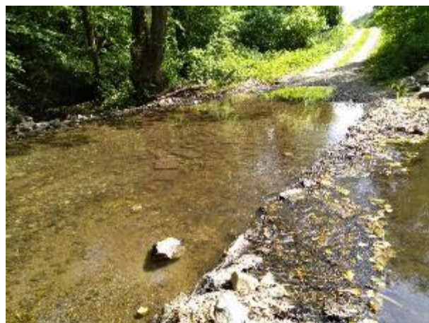
Slika 41. Utvrđeni prijelaz koji zadržava mulj
