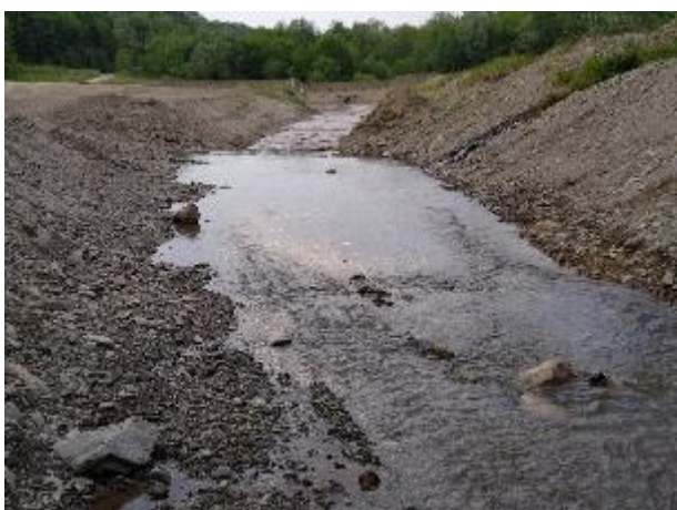
Slika 57. Kanalizirani dio toka s branom za taloženje pijeska
