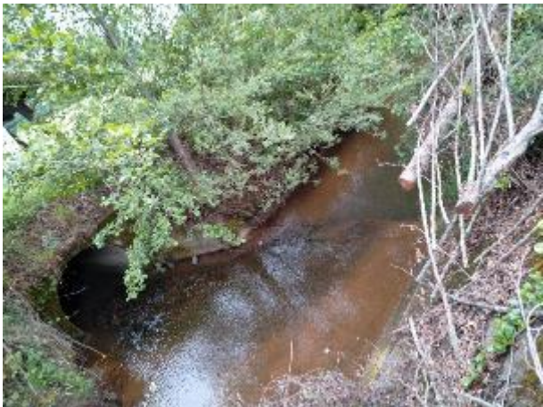
Slika 9. Ispust akumulacije Novo Zvečevo
