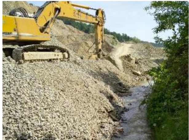
Slika 83. Proširivanje ceste kamenoloma nasipavanjem
