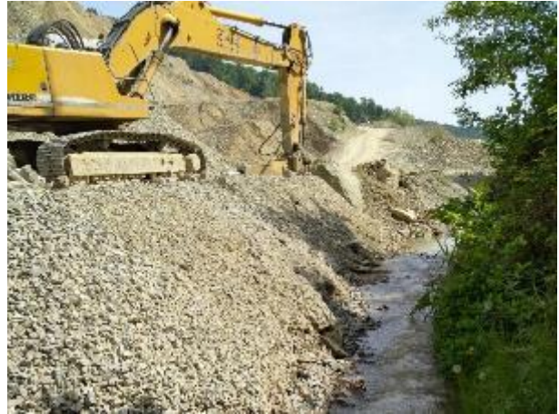
Slika 83. Proširivanje ceste kamenoloma nasipavanjem
