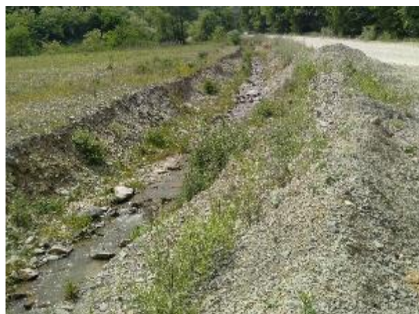
Slika 56. Kanalizirani dio vodotoka
