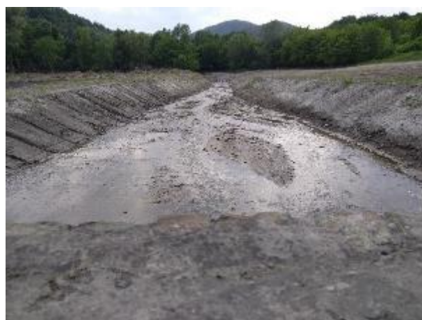
Slika 58. Nedavno iskopani kanal kod taložnog bazena
