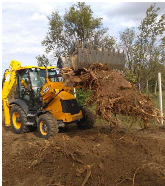
Slika 3. Vadenje panja pomoću radnog stroja
