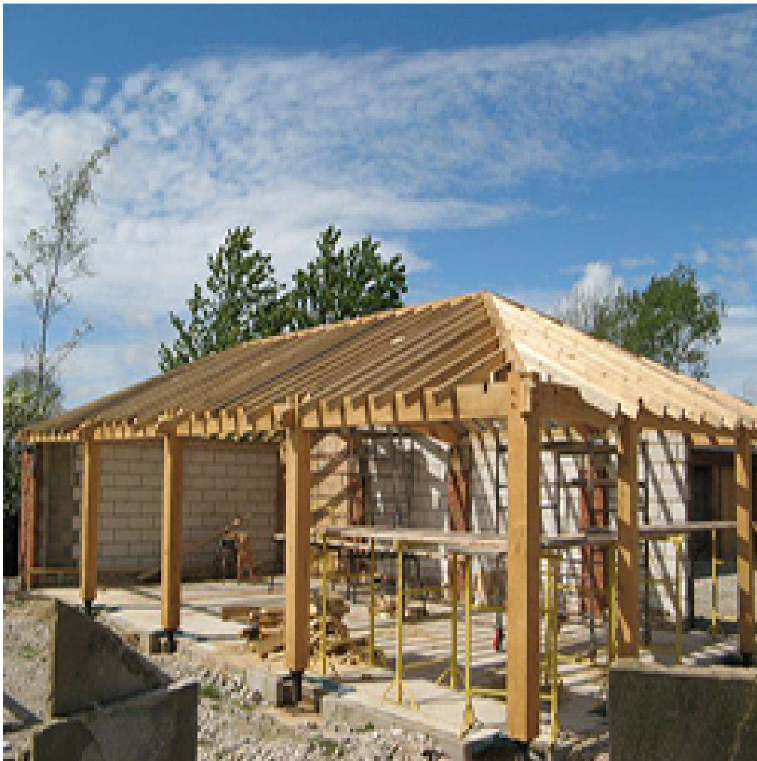
Slika 10 Primjer konstrukcije izrađene s hrastom [10]
