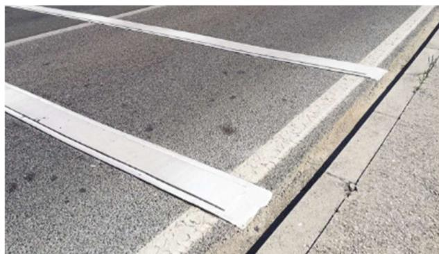
Slika 2 Vibracijske trake [3]
