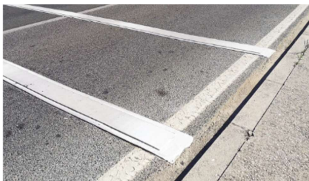
Slika 2 Vibracijske trake [3]
