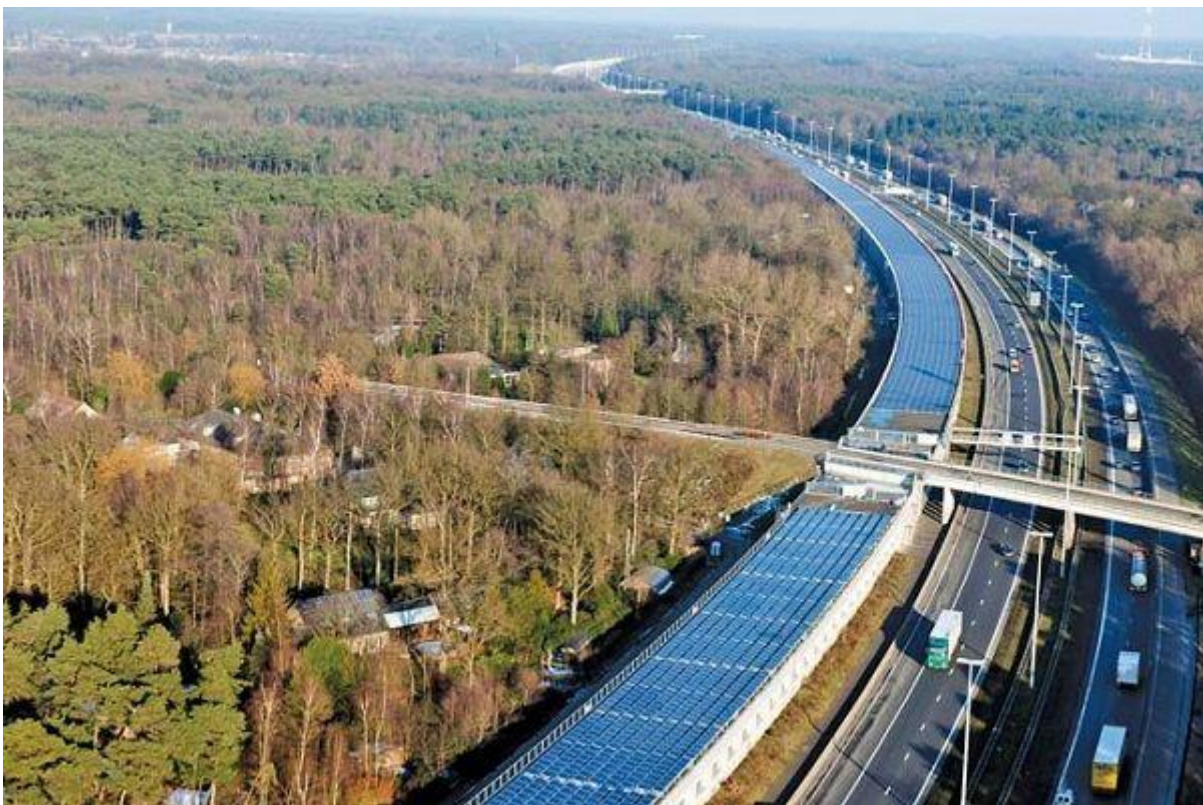
Slika 5.2.1. Solarni tunel za pogon vlaka na jednoj dionici puta u gradu Antwerpen, Belgija
