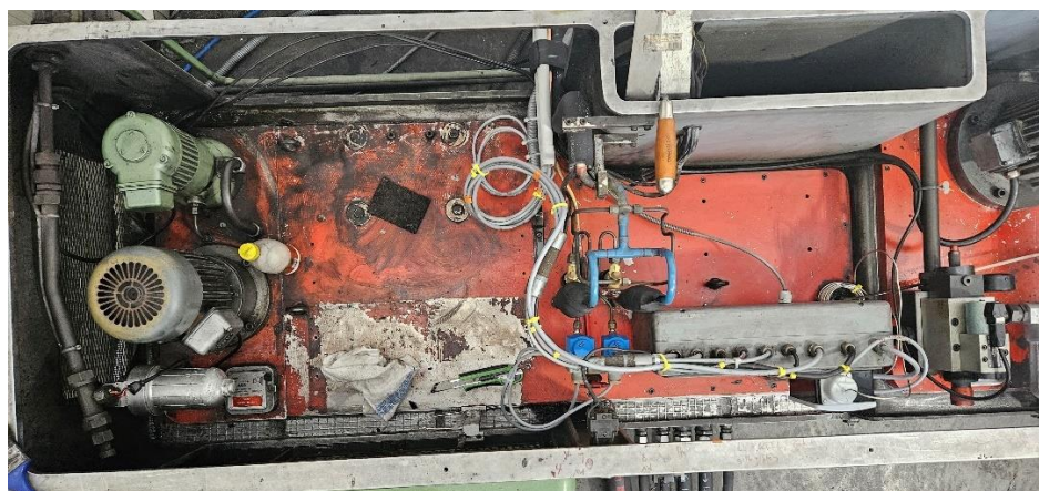
Slika 32. Izgled kućišta hladnjaka nakon ugradnje novog sustava[Autor]
