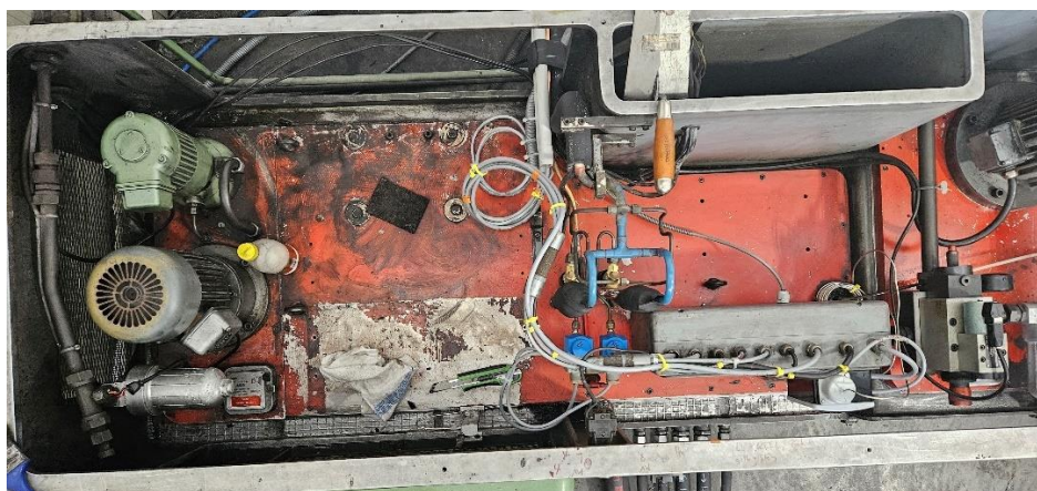
Slika 32. Izgled kućišta hladnjaka nakon ugradnje novog sustava[Autor]
