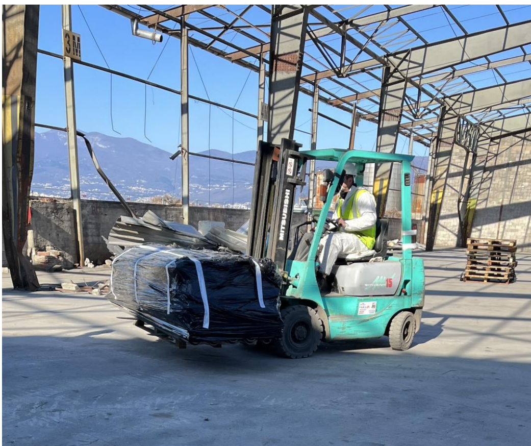
Slika 7. Priprema materijala (otpada) koji sadrži azbest za odvoz sa gradilišta [2]
