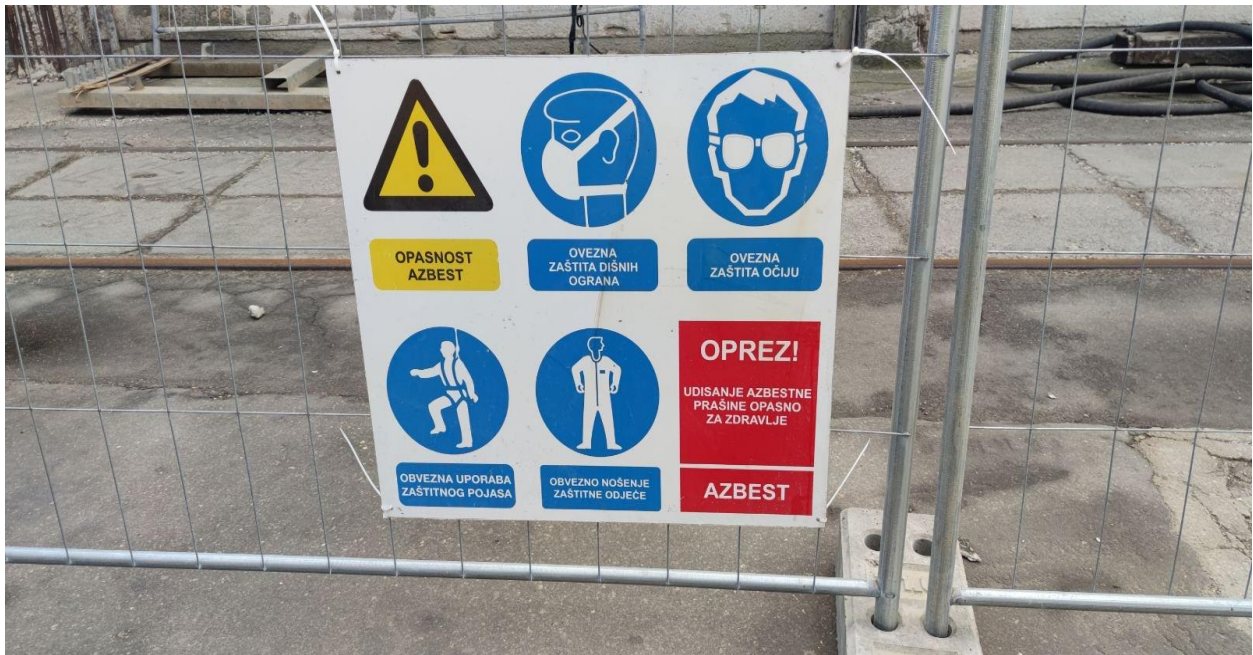
Slika 16. Oznake i znakovi na gradilištu [2]
