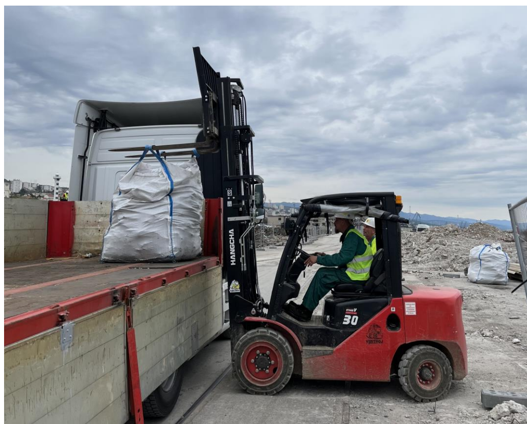
Slika 8. Odvoz građevinskog materijala koji sadrži azbest [2]
