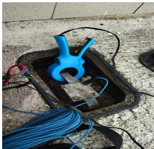
Slika 21. Ispitivanje gromobranske instalacije spajanjem na traku [26]
