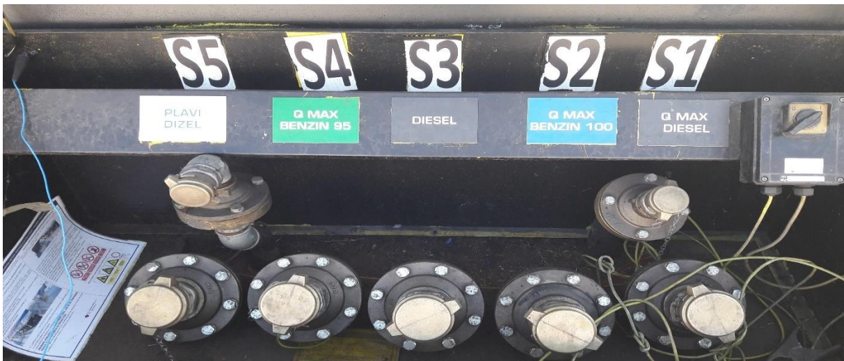
Slika 23. Centralno utakalište goriva [26]
