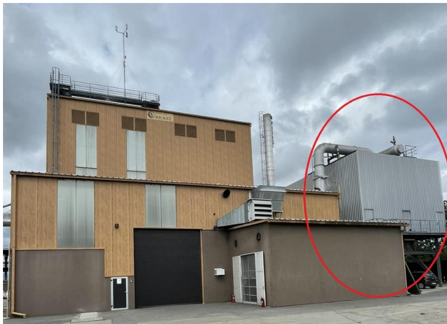
Slika 10. Zračni kondenzator [5]
