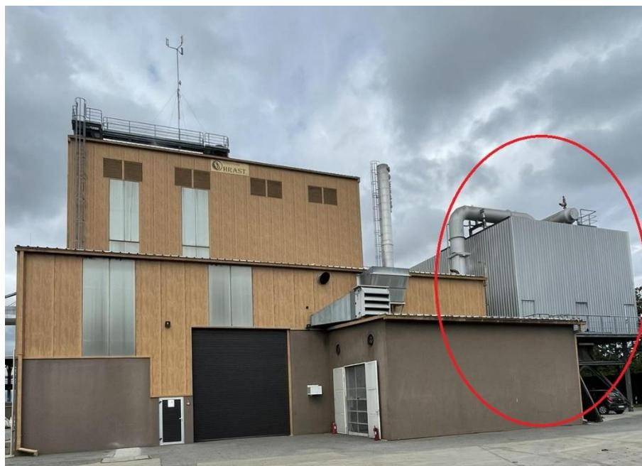
Slika 10. Zračni kondenzator [5]
