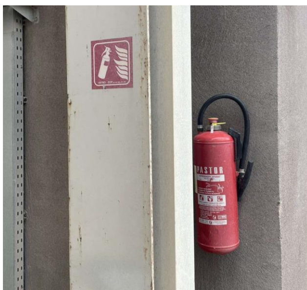
Slika 18. Vatrogasni aparat na dnevnom spremniku sječke [5]
