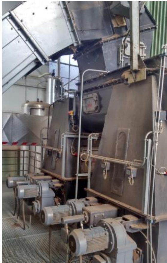
Slika 7. Spremnik goriva ili dozirni uređaj [5]
