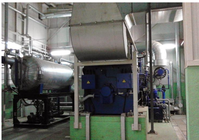
Slika 11. Turbina, generator [5]
