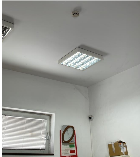
Slika 28. Optički javljač u kontrolnoj sobi [5]
