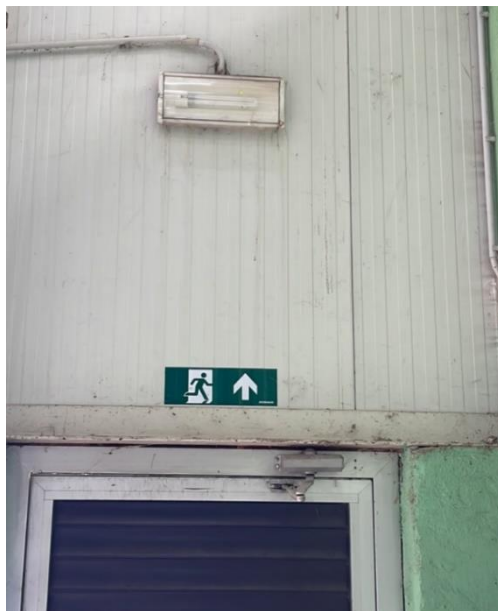
Slika 37. Protupanično osvjetljenje i evakuacijska oznaka [5]
