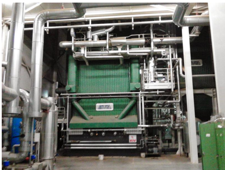
Slika 8. Ložište [5]
