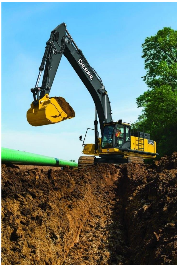
Slika 13: Iskop zemlje (Izvor: https://pin.it/1SHi1dJ )
