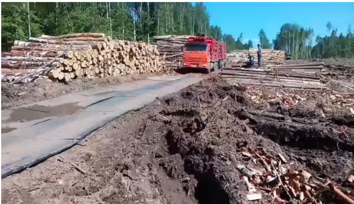
Slika 19. – prolazak šumarskog kamiona na stovarište pomoću Isotrack podloga
