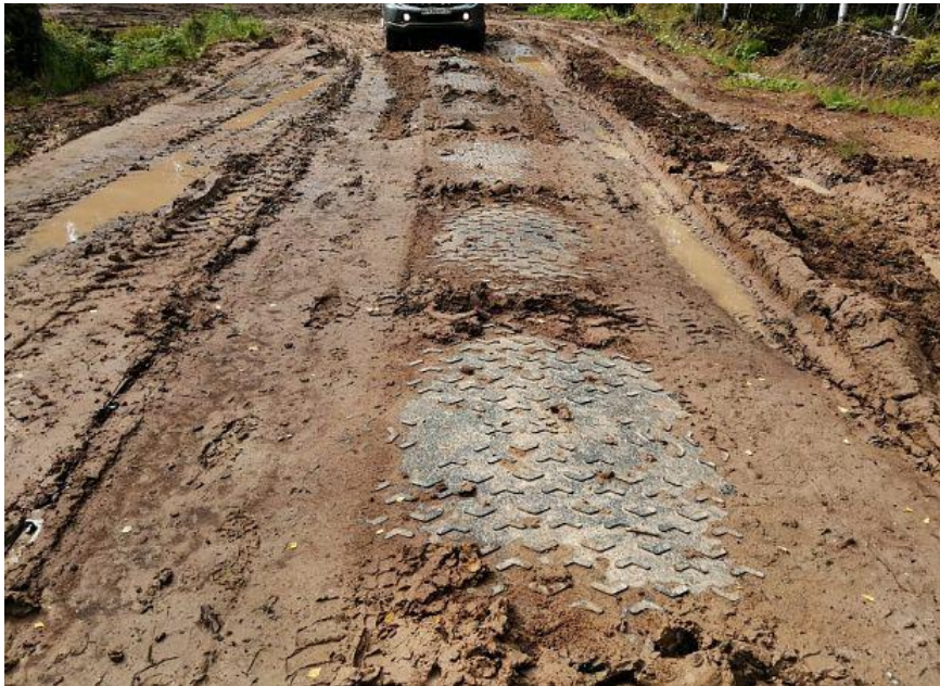
Slika 18. – prikaz isotrack H modela na šumskim kolotrazima
