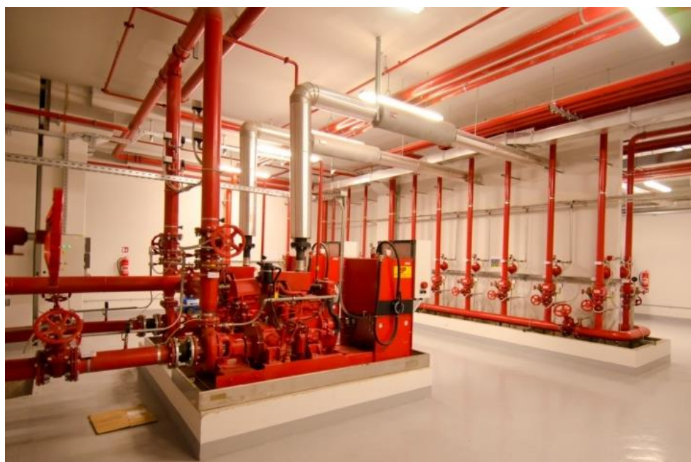
Slika 6: Primjer sprinkler sustava [10].
