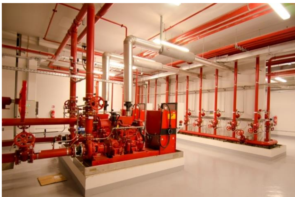
Slika 6: Primjer sprinkler sustava [10].
