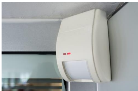
Slika 10. Predodžba vanjskog PIR detektora [33].
