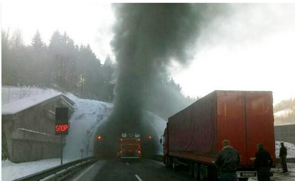
Slika 20. Izlazak dima prilikom požara u tunelu
