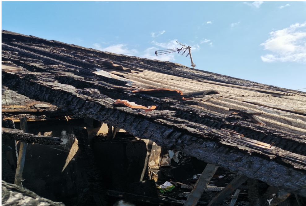
Sl. 23. Sanacija dan nakon požara.[4]
