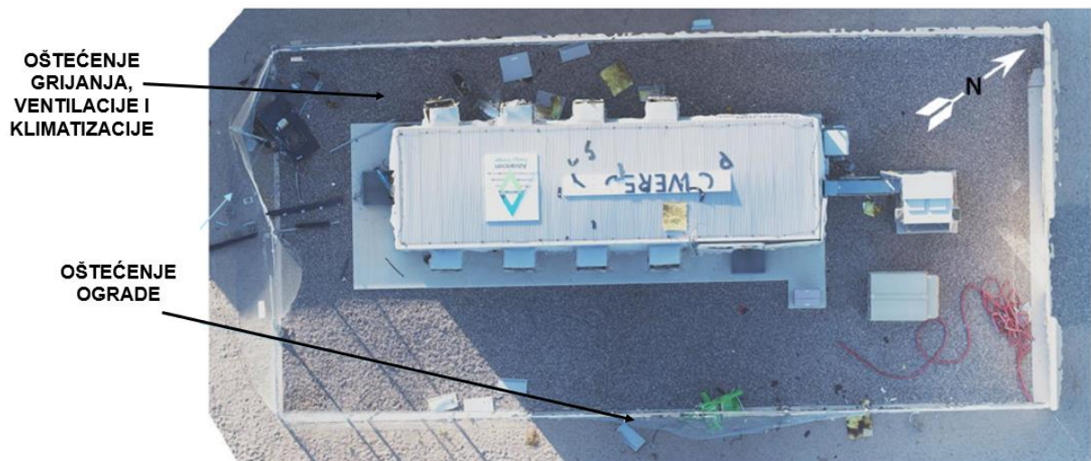
Slika 14. Postrojenje McMicken Battery Energy Storage nakon eksplozije [28]
