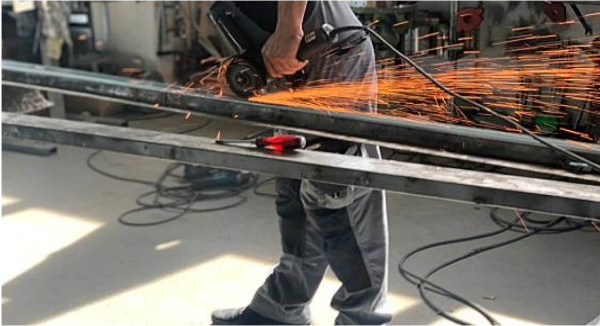
Slika 27. Primjer zavarivanja lamele
