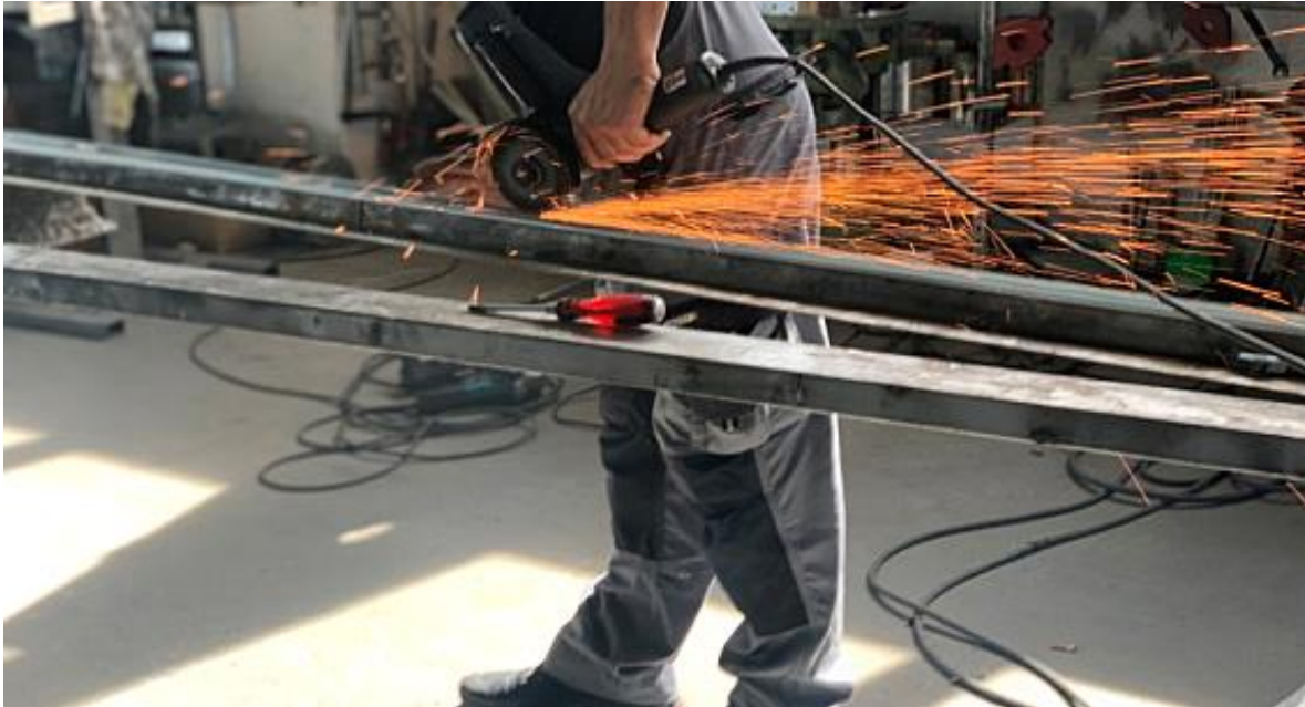
Slika 27. Primjer zavarivanja lamele
