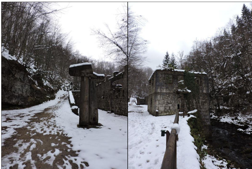
Slika 9: Ruševne zidine stare vodenice (pilane)
