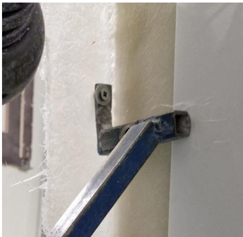
Slika 20. Vijkom pričvršćena „antena“.
