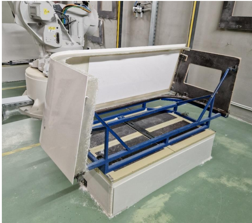
Slika 19. Obloga Wall Corner L na robotskom negativu.
