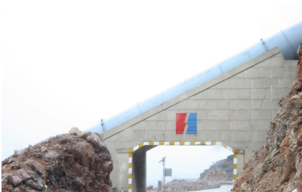
Slika 22 Cijev reverzibilne elektrane [48]
