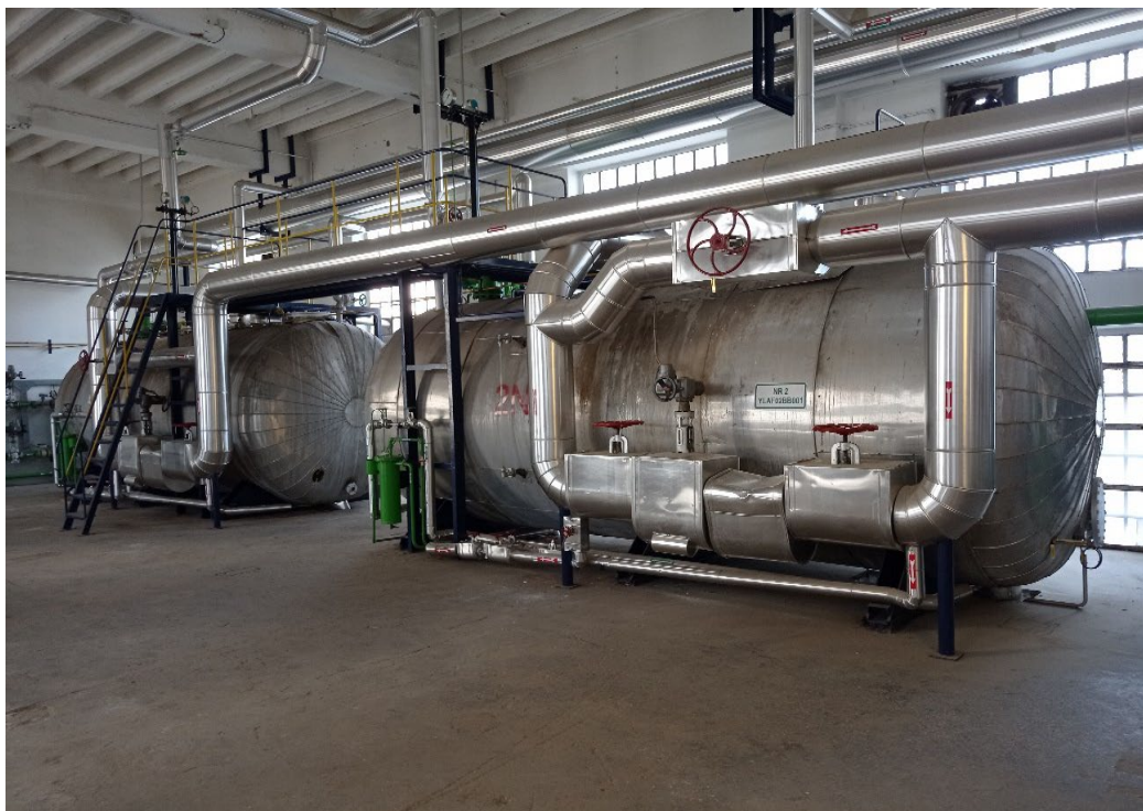
Slika 8. Napojni spremnici vrelovodnog sustava [12]
