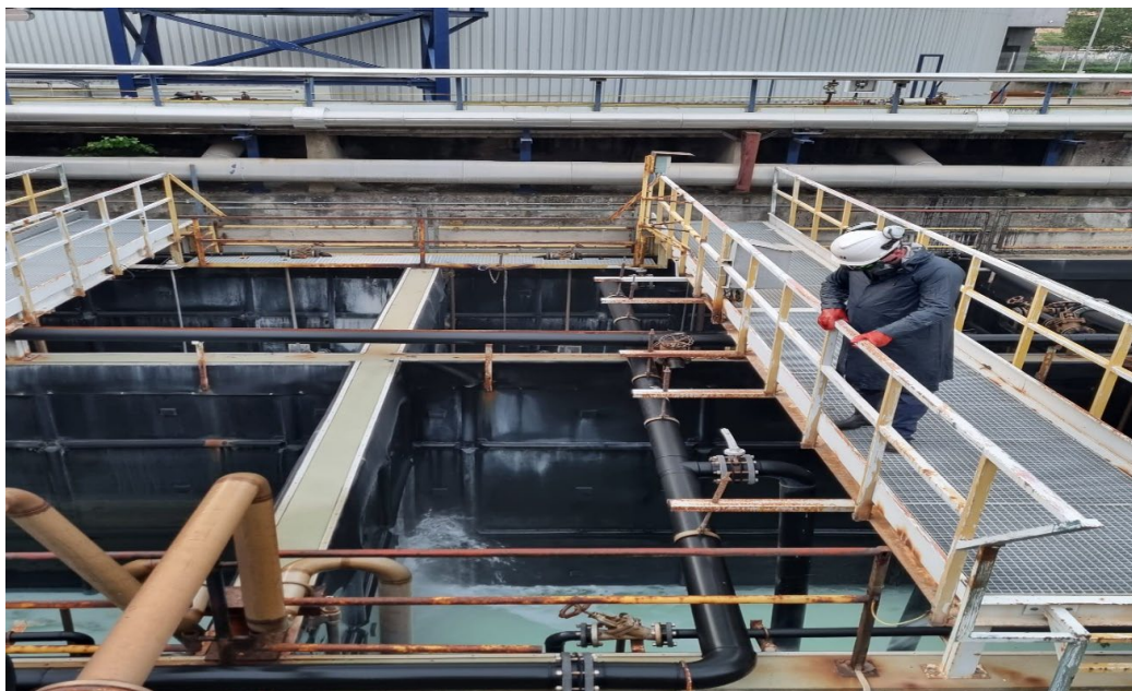
Slika 9. Postrojenje za obradu otpadnih voda [15]
