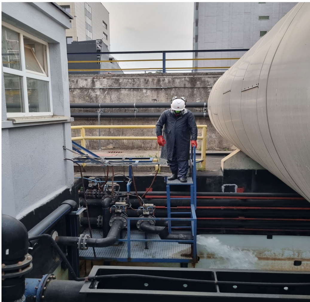
Slika 12. Prepumpavanje neutralizirane vode [18]
